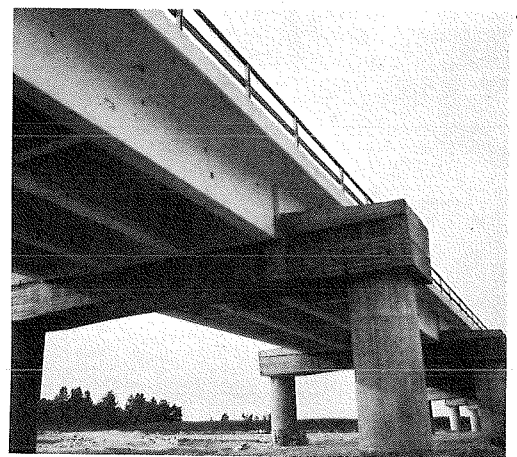
14 - Degradazioni localizzate del viadotto; 15 - Riparazione effettuata con malta espansiva reoplastica; 16 - Applicazione della vernice cementizia impermeabilizzante; 17-18 - Visione del viadotto protetto con la vernice cementizia.
