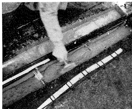
10 - Esempio di utilizzazione di malte reoplastiche nell'esecuzione di giunti di dilatazione per viadotti autostradali.
