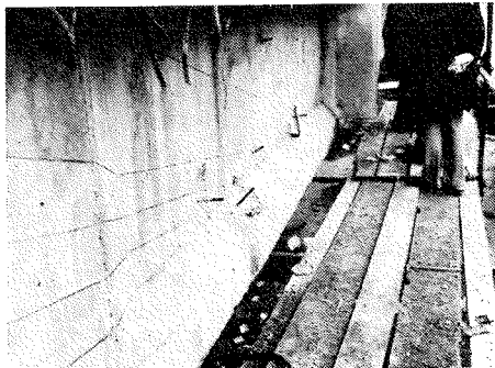
7 - Particolari di iniettori per il riempimento di guaine di cavi scorrevoli parzialmente vuote.
