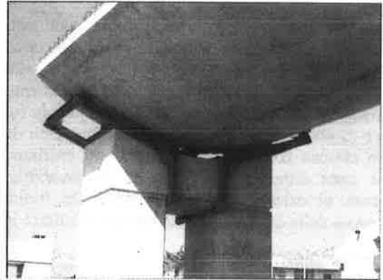
Fig. 12 – Sostegno provvisorio
