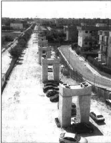
Fig. 2- Pile del viadotto
