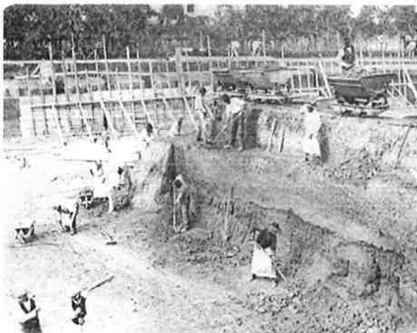
Foto n.°1 1926 la buca della piscina scoperta viene scavata a mano
