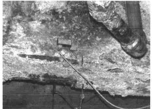
Fig. 5 - Prove per la determinazione della tensione
