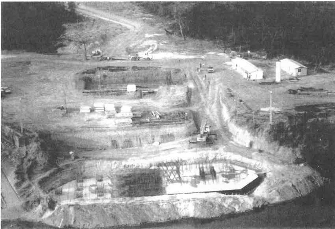
Fig. 2 – Fondazioni dell'antenna e della spalla lato Cuiabà.
