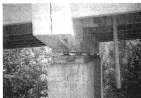
Fig. 8B Inserimento apparecchi d'appoggio
