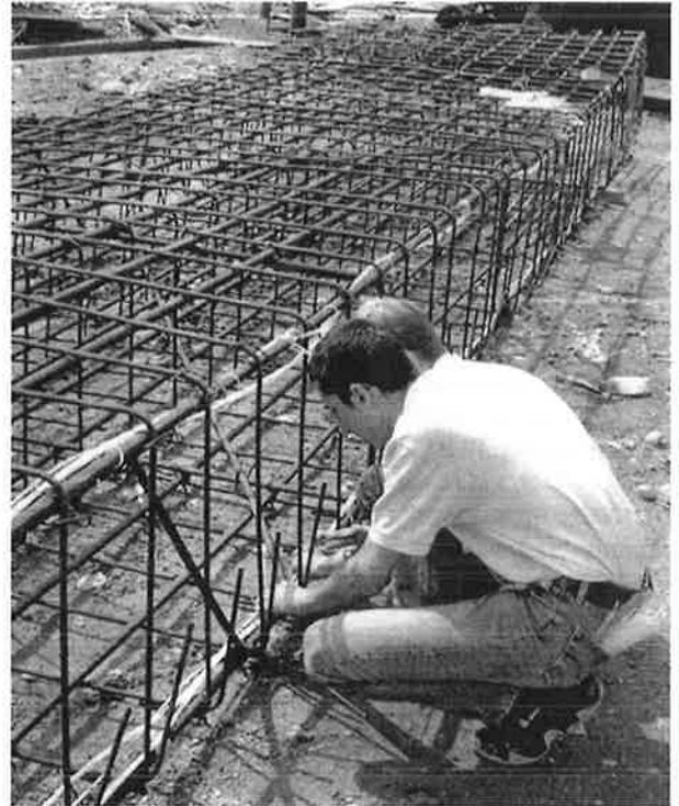
Figura 12: modalità di collegamento dei sensori alle armature di un pannello di paratia.
