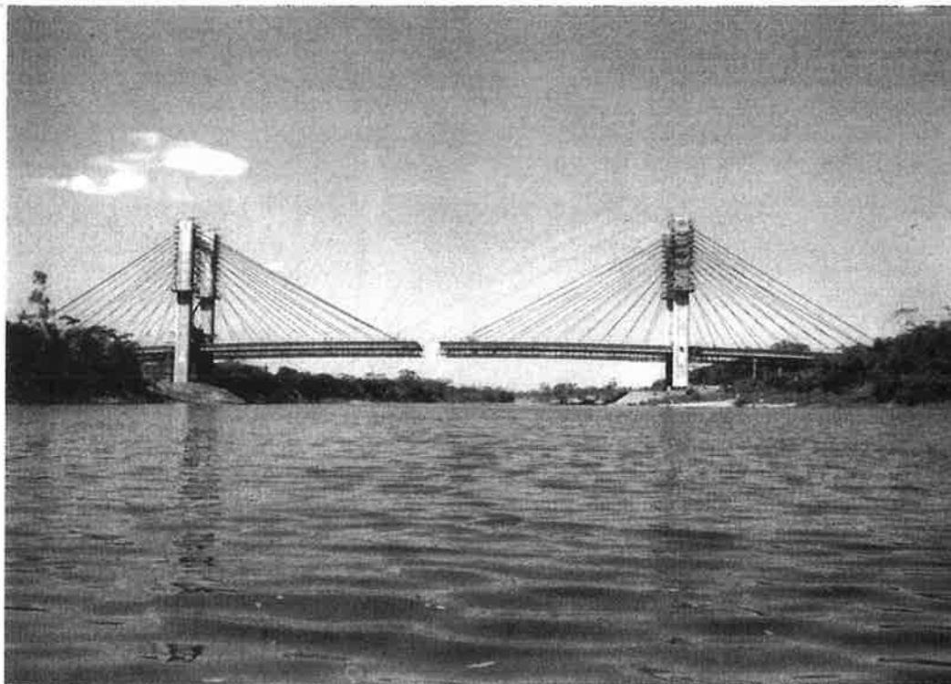
Fig. 13 – Profilo del ponte al completamento dell'avanzamento quando manca solamente il concio in chiave.
