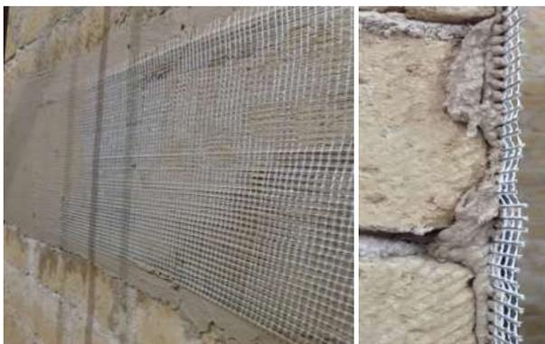
Figura 3 – Applicazione del rinforzo: stesa della mano di aggancio e applicazione del tessuto in trefoli di acciaio
