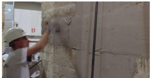
Figura 5 – Applicazione del rinforzo: stesura del secondo strato di malta a coprire il tessuto di rinforzo
