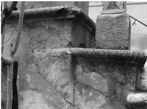
Figura 4 – Dettaglio della scala esterna di Villa Sarti a Lucca (1915-1916). Le reintegrazioni con malte cementizie, differenti dal supporto, non hanno arrestato i fenomeni di degrado e per di più risultano esteticamente diverse dai materiali in opera.
