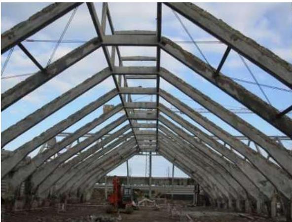
*Figura 3 - Stabilimento ex-Agrimont, ora Area Complessi, Porto Marghera, Capannone costruito con il metodo Hennebique parzialmente sopravvissuto alla demolizione, anni Trenta*
