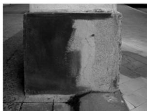
Figura 19 – Intervento erraneo di tinteggiatura di una p.a.
