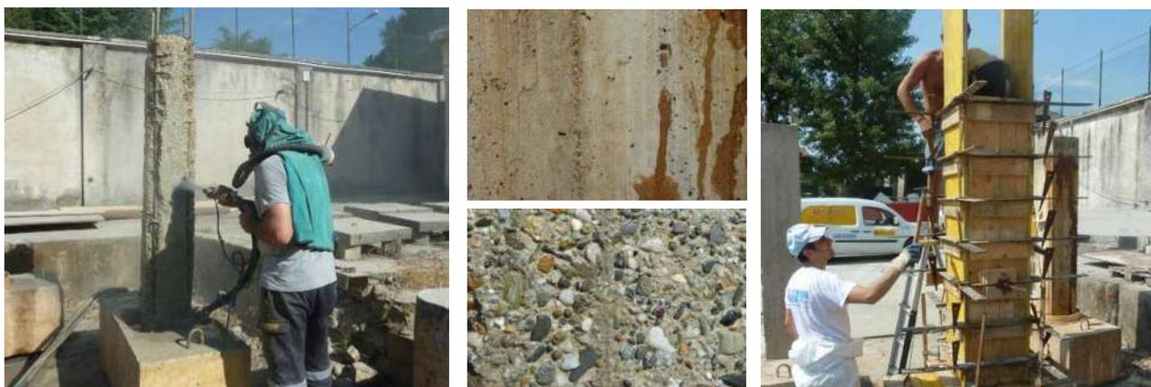
Figura 6. Sabbatura del pilastro e confronto delle superfici prima e dopo il trattamento (sinistra) e getto della camicia in calcestruzzo ad elevate prestazioni (destra)
