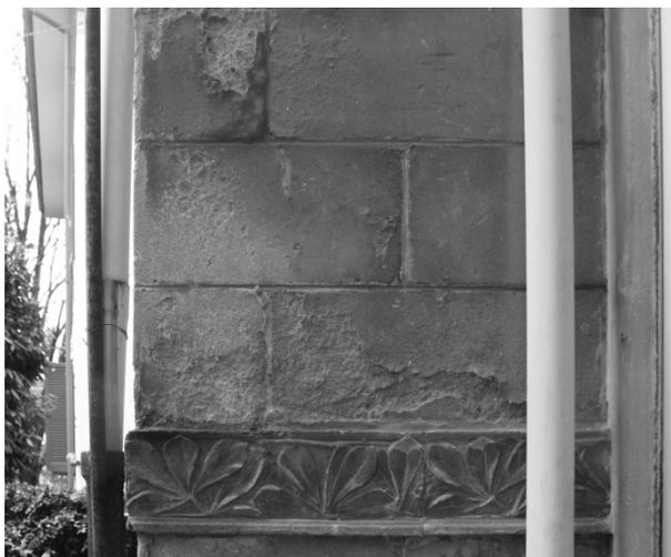
Figura 3 – Dettaglio di Villa Sarti a Lucca (1915-1916). L'edificio è stato progettato da Giovan Lelio Menesini. Nell'immagine sono visibili i segni di degrado dei blocchi in c.a. nelle pareti perimetrali.
