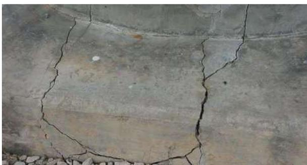
Figura 2 – Fessurazione di un elemento strutturale ad opera di una aggressione chimica [2]
