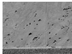
Figure 21 – 22 – Esempio di corretta reintegrazione di una mancanza in una lastra armata di travertino artificiale
