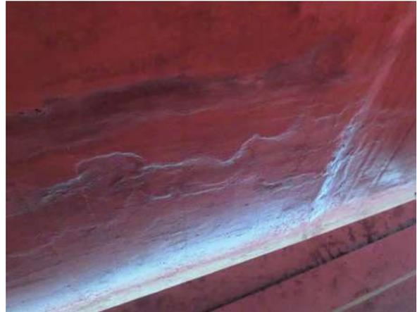
Figura 6 - Colature e rigonfiamenti dovuti a calcestruzzo semifluido (al di sotto del bordo inferiore della slipform)
