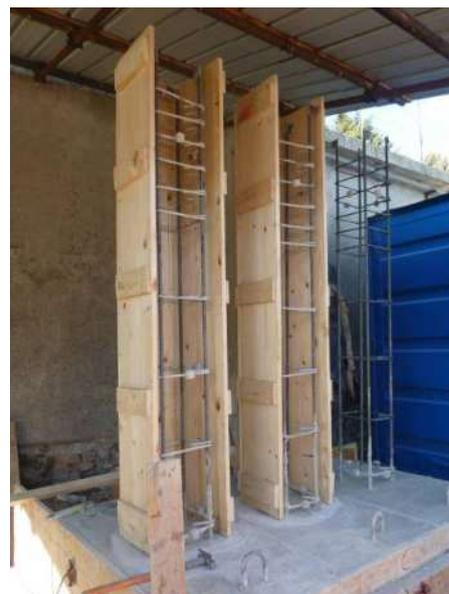
Figura 1. Geometria dei campioni (a sinistra) e particolare della casseratura dei tre pilastri (a destra)
