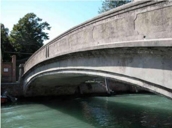
*Fig. 2 - Ponte-tubo per le canalizzazioni del gas e passerella dell'ing. E. Giay di oltre 18,0 m di lunghezza, costruito con brevetto Hennebique nel 1907 sul canale de l'Arzere a S. Marta, prima "traccia" sopravvissuta dell'utilizzo del c.a. faccia a vista in città*
