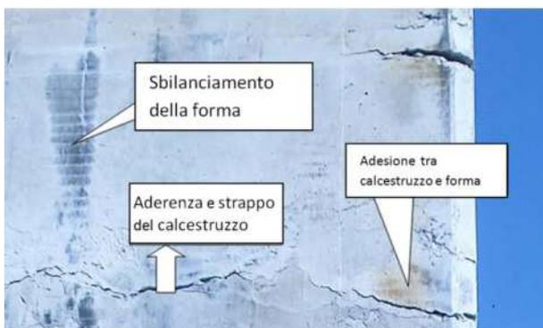
Figura 5 - Difetti dovuti a trascinamento e strappo
