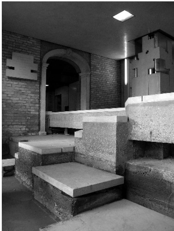
*Fig. 7 - Carlo Scarpa, restauro della Fondazione Querini Stampalia, 1961-63, la vasca di contenimento in c. esibisce il difficile contatto diretto delle superfici di calcestruzzo con l'acqua salmastra con evidenti segni di degrado*
