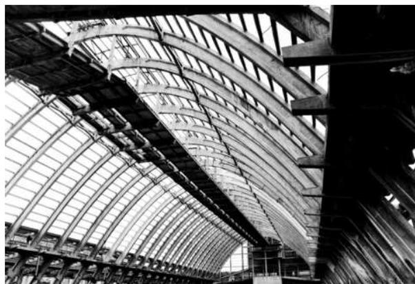
Fig. 5 - Capannone, anni sessanta, Porto Marghera, Area ex-Agrimont Complessi, le strutture degradate dalla lunga esposizione agli agenti atmosferici dopo l'abbandono e alla risalita capillare di agenti aggressivi dal terreno inquinato attendono un intervento di recupero
