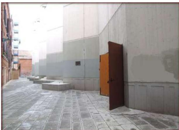
*Figura 8- arch. E. Capuzzo e ing. G. Cocco, Palazzetto dello Sport all'Arsenale (1973-77), involucro massivo in c. a. realizzato utilizzando cemento bianco ed inerti chiari con l'intento di richiamare il colore della pietra d'Istria del contesto storico*
