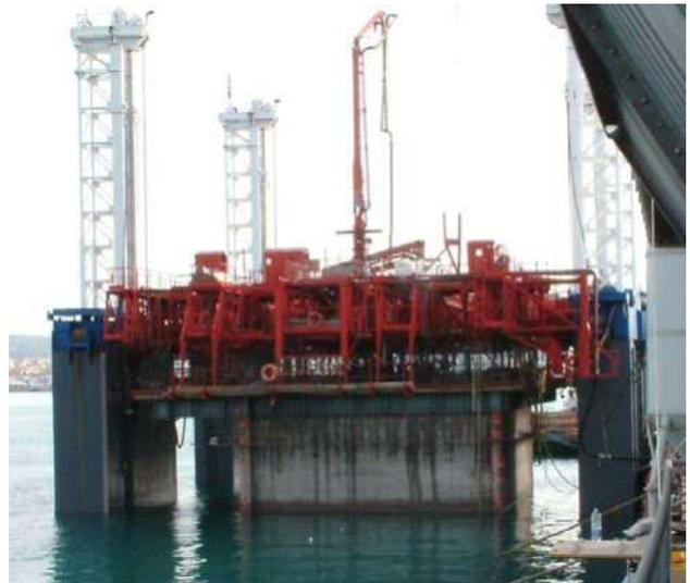
Figura 3 - Uso di slipform per costruire casseri a mare. Il cassero viene sollevato progressivamente mediante 4 gru. Non si impiegano le barre di sollevamento [4]
