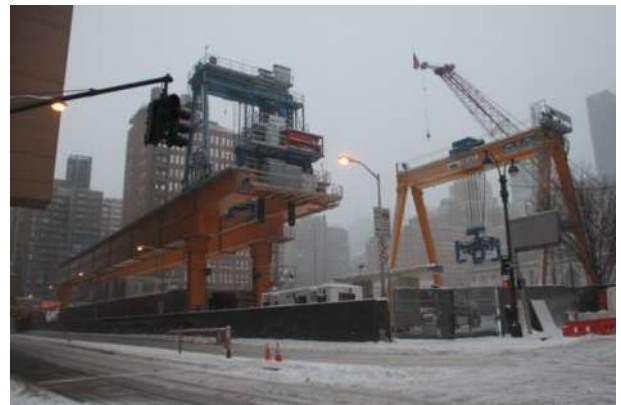
Figura 7 – Il carrellone gommato e l'attrezzatura di varo
