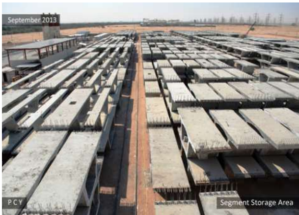
Figura 13 – Area di stoccaggio impianto di prefabbricazione
