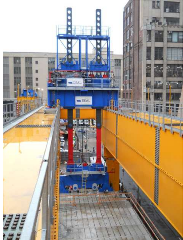
Figura 13 – Il sistema di calaggio
