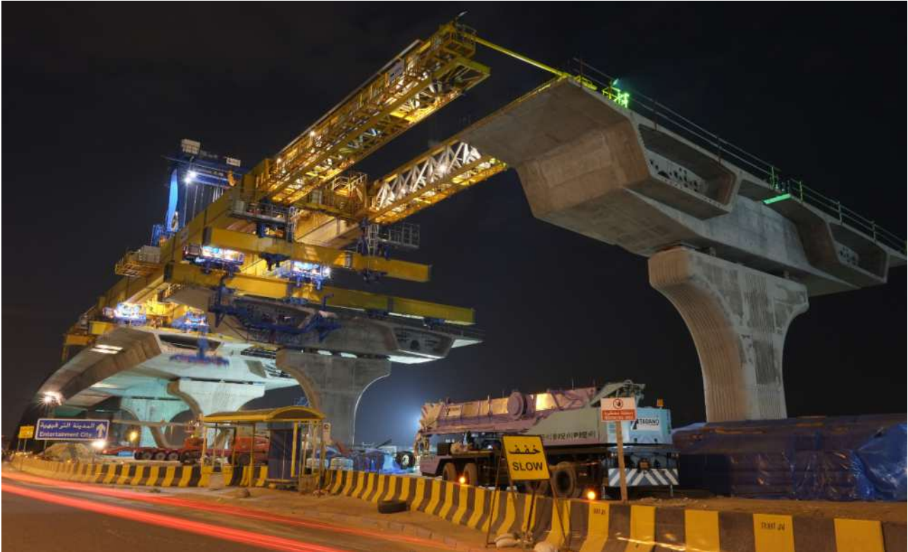
Figura 24 – Vista fase di costruzione – Metodo “Span-By-Span”
