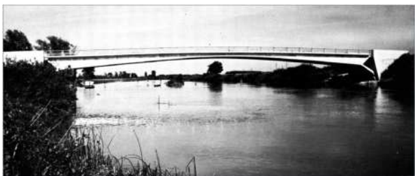
Fig. 1 – Ponte sul Fiume Marne ad Annet – Francia (1948)
