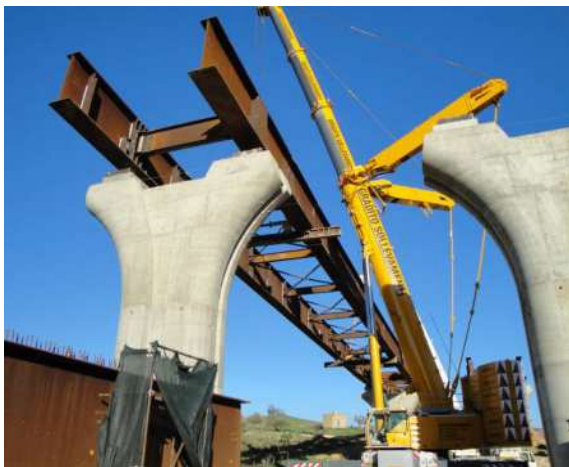
Figura 5 – Montaggio di intere campate pre-assemblate a terra e saldatura in quota
