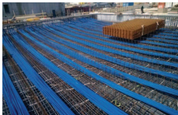
Figura 4- L'armatura di un solaio a cavi post-tesi
