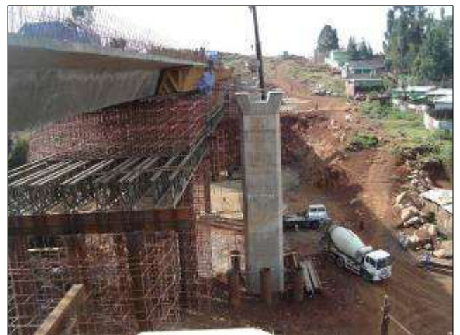
Figura 13 - Fasi esecutive. Allestimento di ponteggi su colonne in acciaio per il sostegno della cassaforma di impalcato
