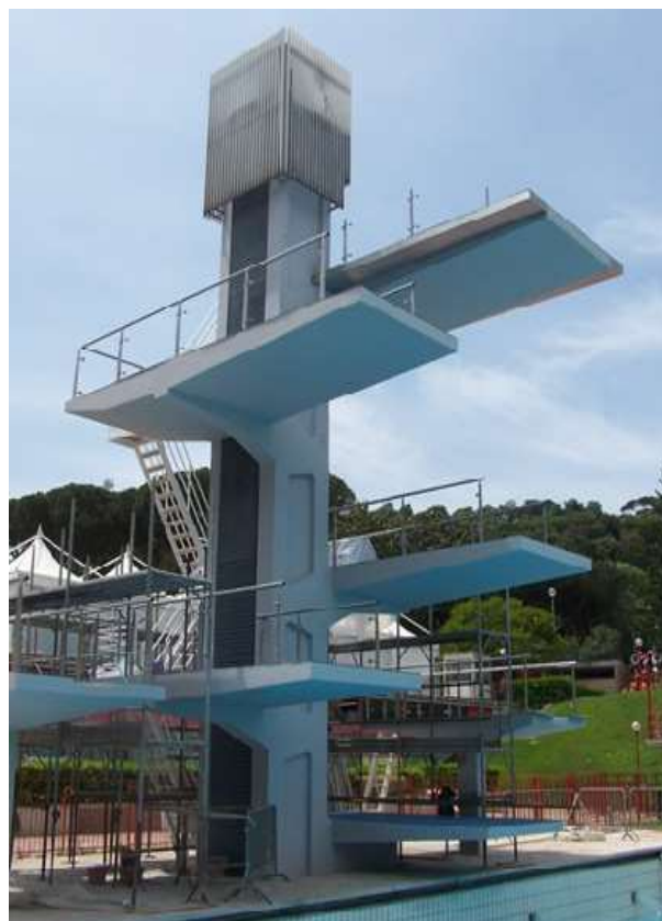
Figura 16- Vista del trampolino verso la fine dei lavori
