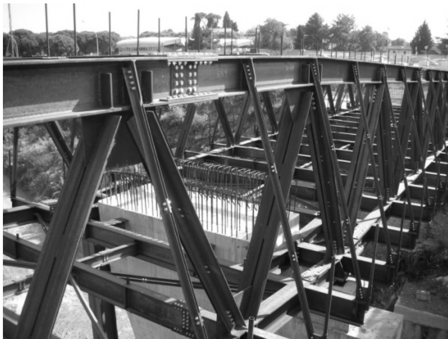
Figura 3 - Vista della trave di banchinaggio
