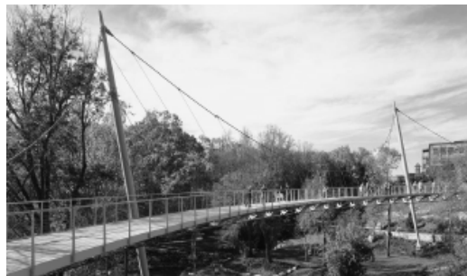
Figura 2 – Tre ponti in curva sospesi di Jörg Schlaich, con la sezione trasversale dell'impalcato che ne illustra il funzionamento. Ponte pedonale a Kelheim (a) sul canale che unisce il Reno al Danubio, con impalcato costituito da una trave ad anello precompressa in cemento armato. Ponte pedonale sopra Gahlensche Strasse a Bochum, Germania (b), sospeso lungo il bordo dell'impalcato interno alla curva. Ponte pedonale sopra il Reddy River a Greenville, North Carolina, USA (c), sospeso lungo il bordo dell'impalcato esterno alla curva.
