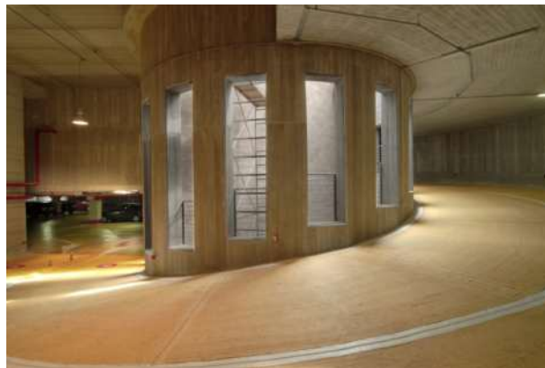
Figura 2 – Rampa circolare interna
