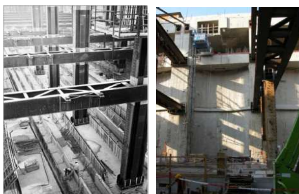
Figura 15 – Le colonne e i telai trasversali
