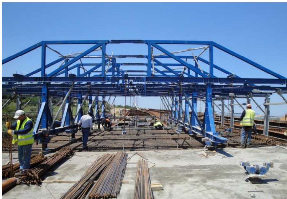
Figura 6 - Attrezzatura di getto nella fase di posa in opera delle armature
