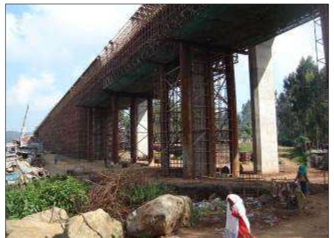
Figura 15 - Fasi esecutive. Ponteggi in acciaio a sostegno della cassaforma della seconda carreggiata
