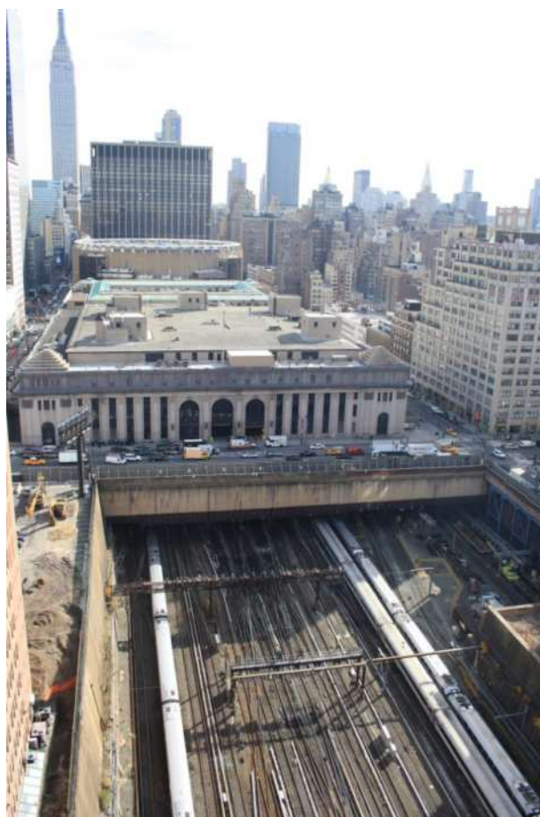
Figura 3 – Area di cantiere
