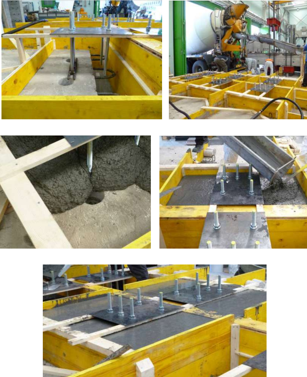
Figura 3. Fasi realizzative dei campioni di laboratorio
