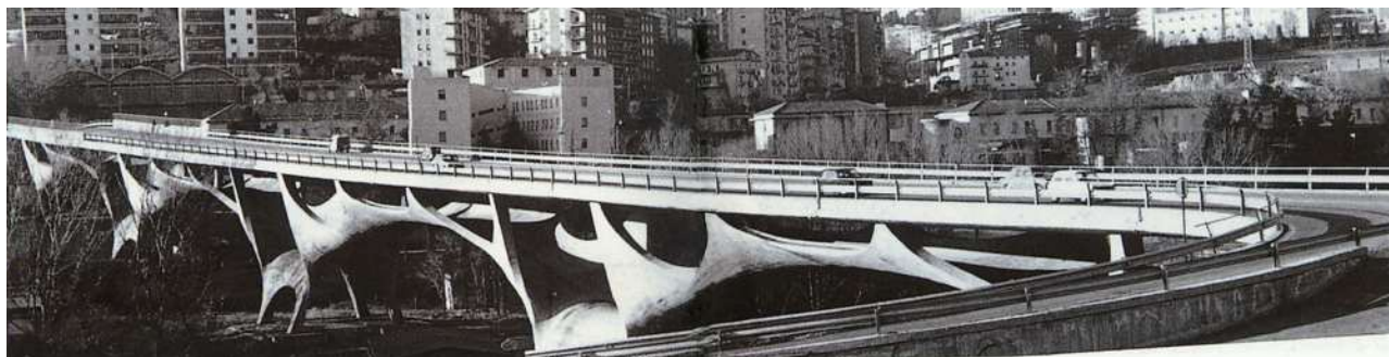
Figura 1 – Sergio Musmeci, ponte sul Basento a Potenza
