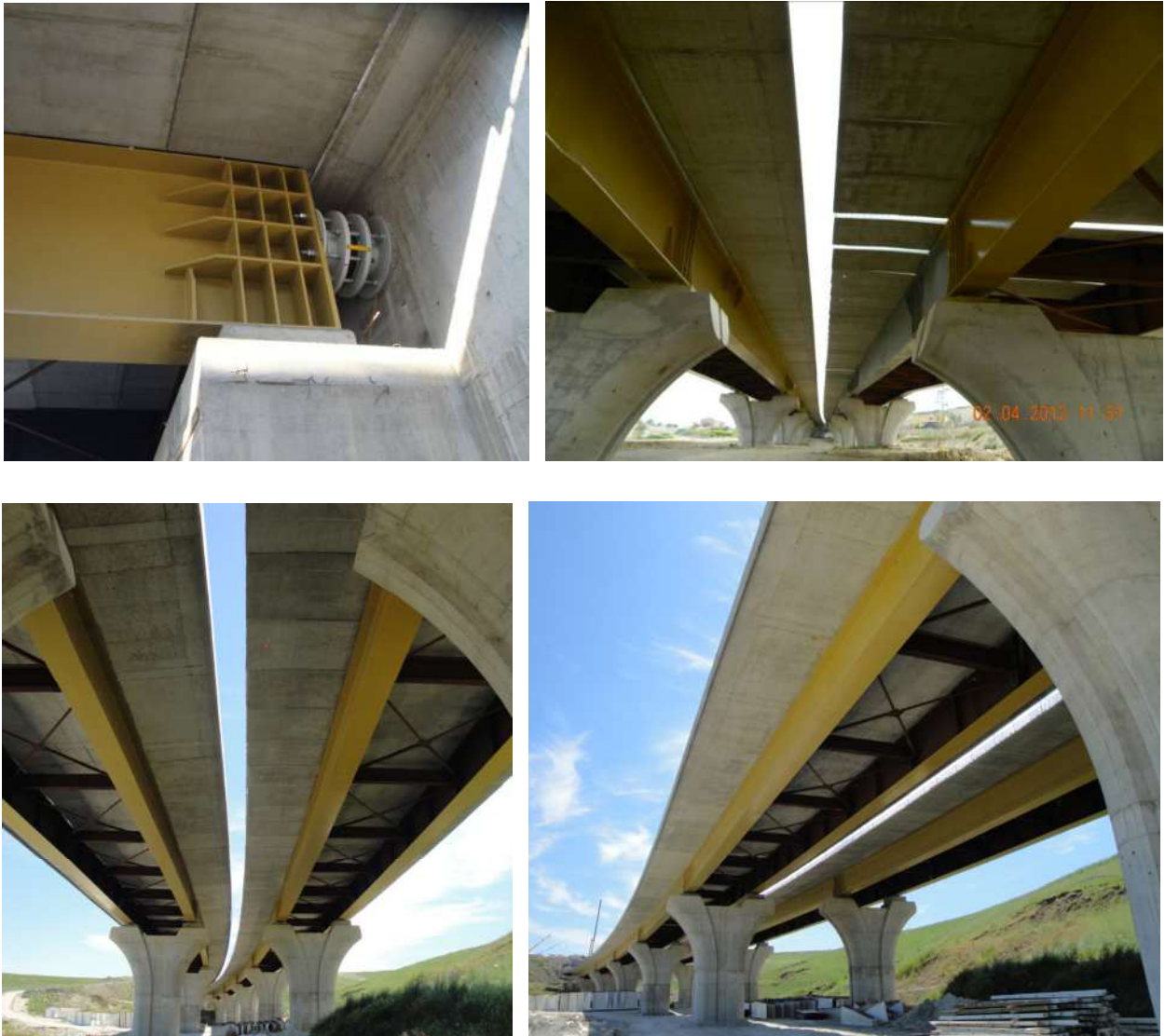
Figura 10 – Viste dal basso e dispositivo di vincolo dinamico
