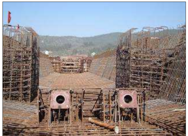
Figura 11 - Fasi esecutive. Armatura interna di impalcato e ancoraggi dei cavi
