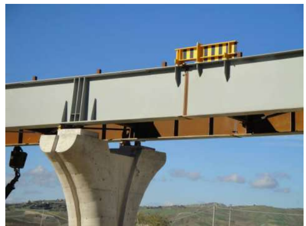
Figura 5 – Montaggio di intere campate pre-assemblate a terra e saldatura in quota
