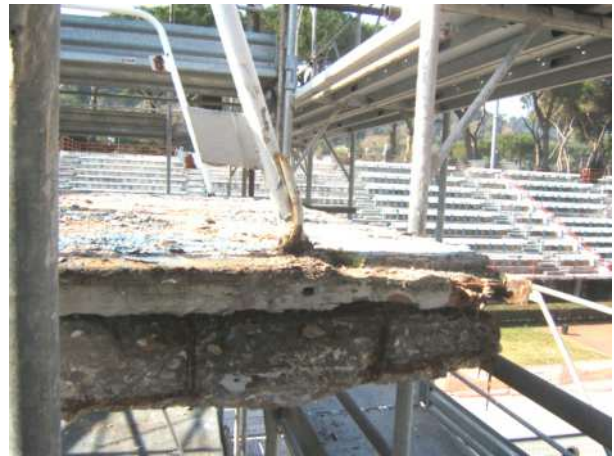
Figura 8 – Il degrado interessava anche le piattaforme
