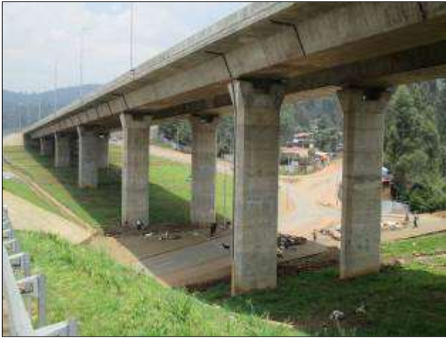
Figura 1 - Vista dell'intradosso a strutture ultimate
