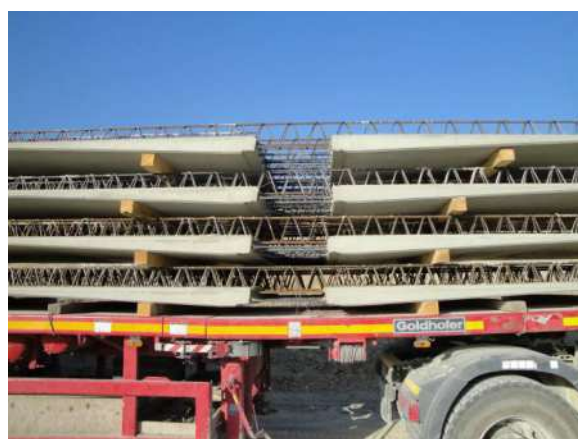
Figura 9 - Costruzione e trasporto predalle a spessore variabile
