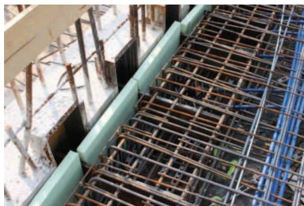
Figura 5- Particolare dei giunti provvisori
