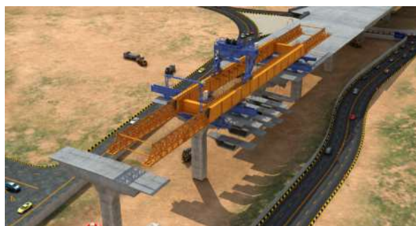
Figura 4 – Impalcato a conci - Varo "Span-By-Span"
