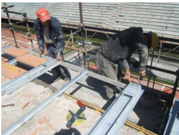
Figura 15 - Particolare dell'allargamento delle pedane
