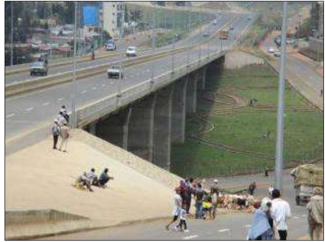
Figura 2 - Vista del piano stradale
