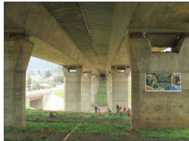
Figura 4 - Particolare intradosso e ritegni antisismici trasversali
