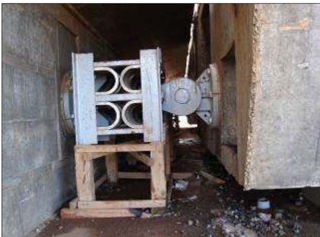
Figura 12 - Fasi esecutive. Montaggio del ritegno antisismico
