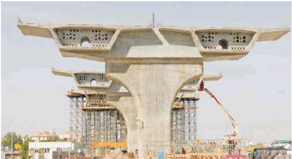
Figura 6 – Pila tipica e diaframma “testa-pila” monolitico
