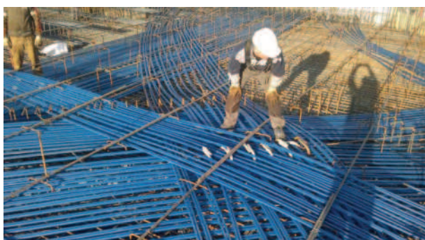
Figura 7- Cavi di post-tensione disposti su tre livelli
