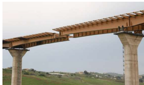
Fig. 9 - Varo carpenteria metallica
