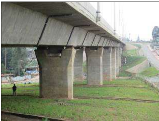
Figura 3 - Particolare pile e impalcato
