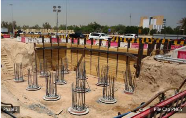
Figura 7 – Pali trivellati
