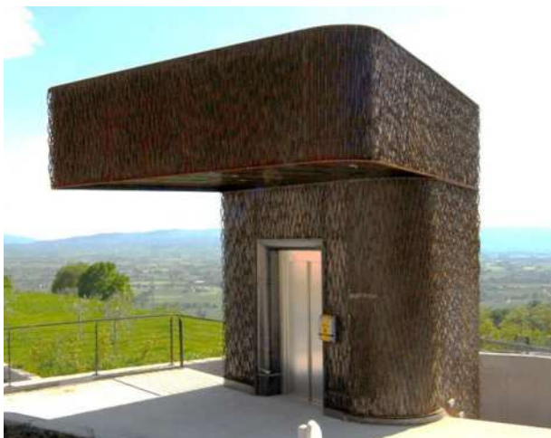
Figura 12 – Corpo ascensore, particolare
