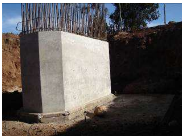
Figura 9 - Fasi esecutive. Pile in corso di costruzione
