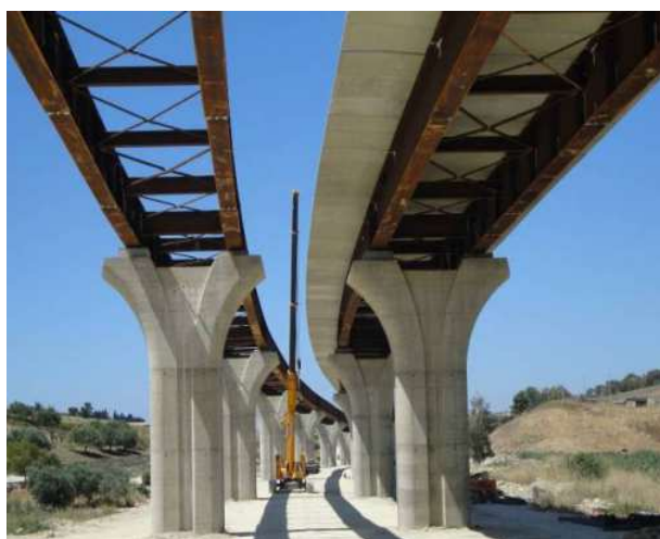
Figura 2 - Vista centrale dei due viadotti affiancati
