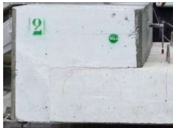
Figura 11. Panorama fessurativo in corrispondenza del carico massimo – prove 1 e 2
