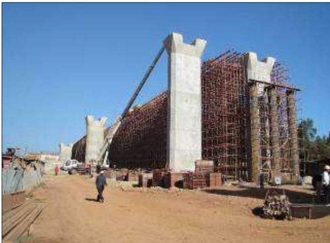
Figura 10 - Fasi esecutive. Inizio lavori di impalcato, allestimento di ponteggi commerciali (successivamente realizzati con strutture in acciaio)
