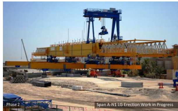
Figura 22 – Attrezzatura Varo L75 LG 1200/75
