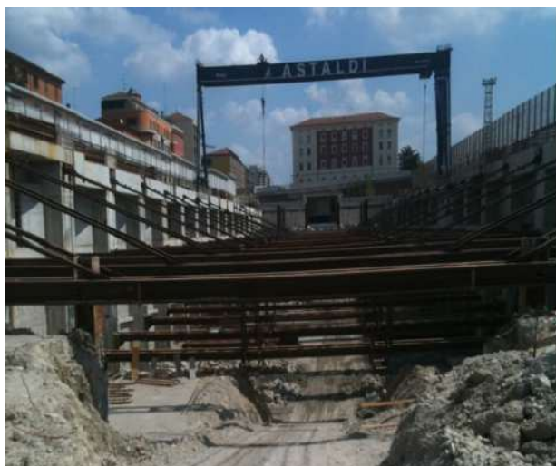
Figura 13- I diversi ordini di puntoni metallici in fase di scavo
