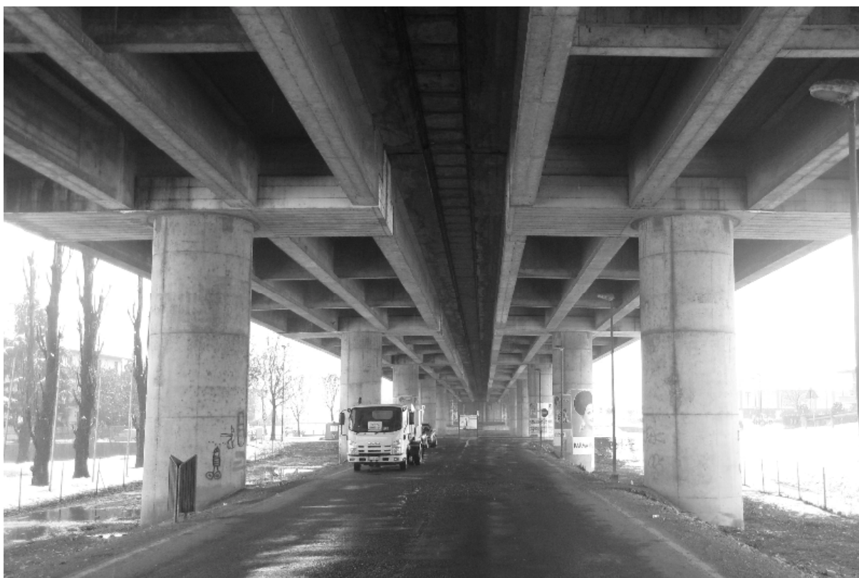
Figura 1 – Il viadotto prima dell'intervento
