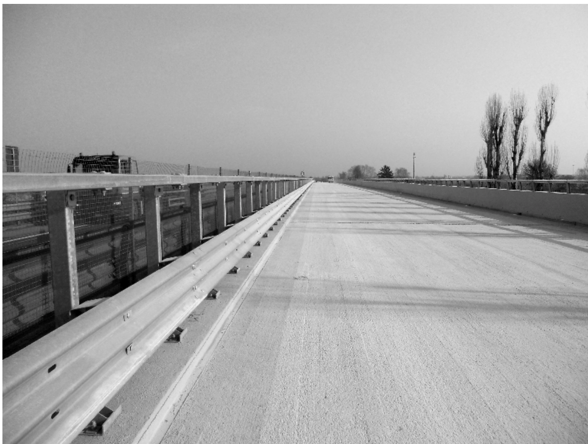
Figura 6 – L'impalcato completato, prima della stesa della pavimentazione bituminosa
