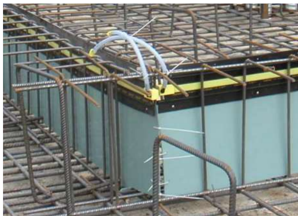
Figura 7 - Elemento di prefessurazione
