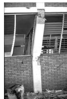
Figura 3 - Esempio di "captive column"
