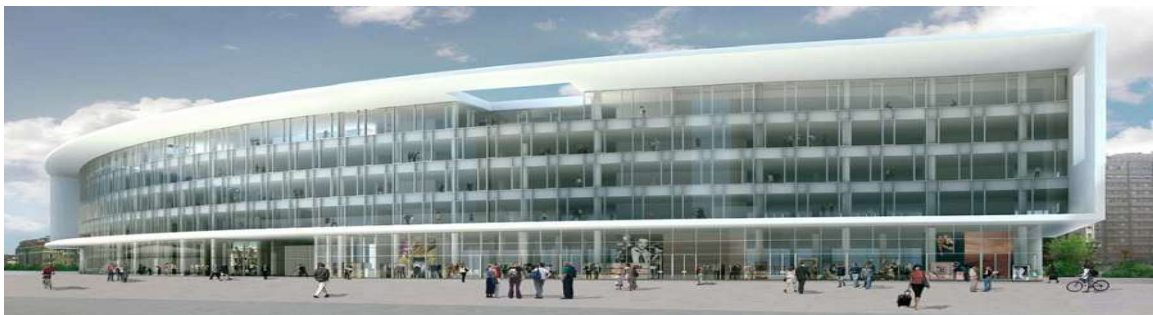
Figura 1 - Vista da Podio Garibaldi Repubblica
