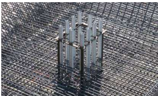
Figura 16 - Inserti di collegamento nelle platea
