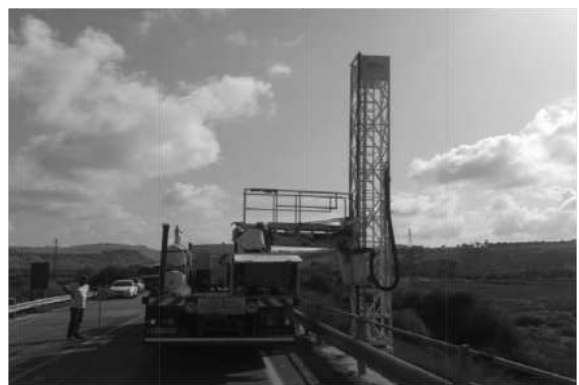
Figura 11 - Operazioni di ispezione con l'ausilio di Bay Bridge
