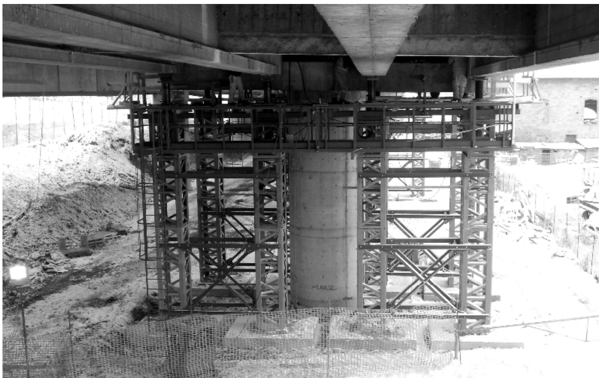
Figura 3 – Fase di sostituzione dei dispositivi di appoggio dell'impalcato
