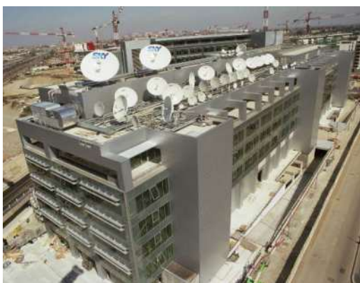
Figura 9 - Antenne di emissione segnale
