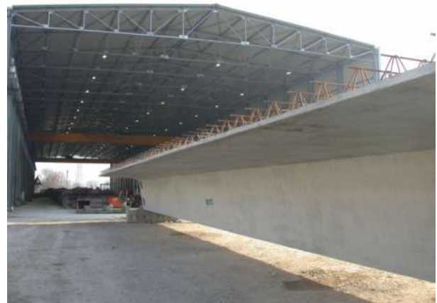
Figura 4- Prefabbricazione Travi V160
