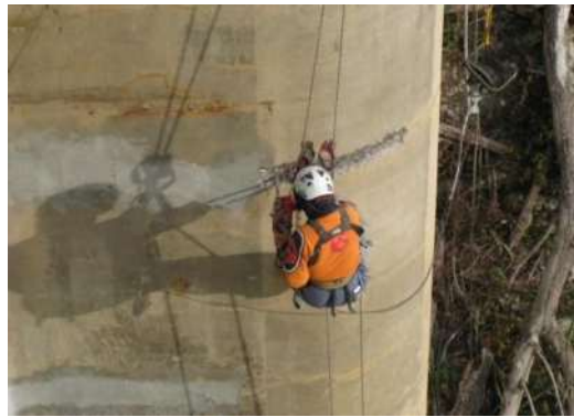
Figura 12 –Diga Val Noci 2008
