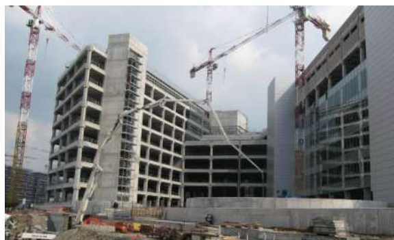
Figura 14 - Strutture prefabbricate ed. n.1 e n.2
