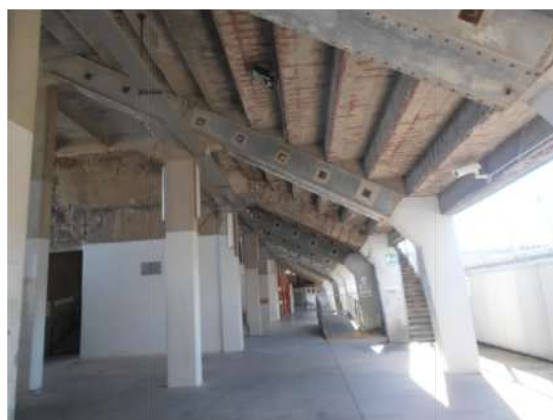
Figura 3 - Interventi con la tecnica del "beton plaque"
