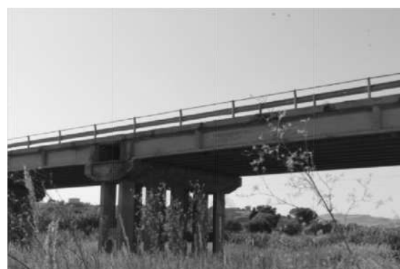
Figura 3 - Viadotto Ipsas I
