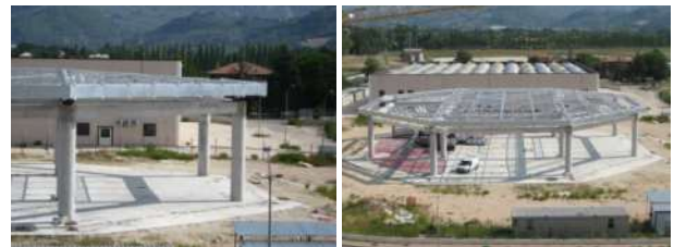
Figura 15 - Strutture metalliche della copertura
