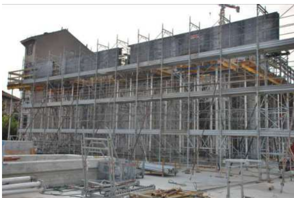
Figura 28 - Fase di montaggio dei conci della trave parete ovest
