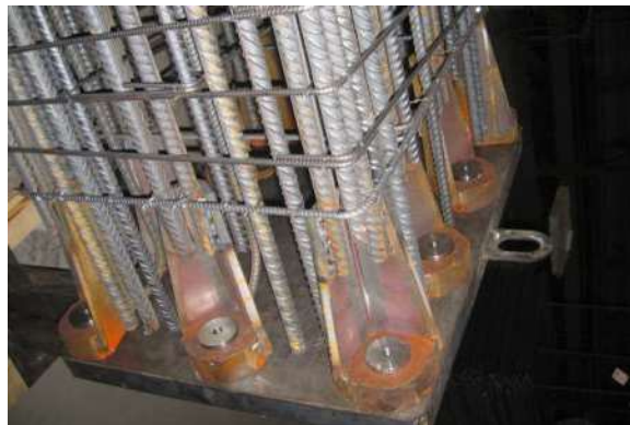
Figura 17 - Inserti speciali alla base dei pilastri
