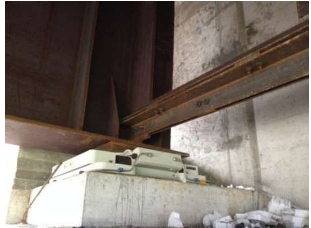
Figura 10 – Apparecchi di appoggio spalle con sistema di dissipazione oleodinamico integrato FIP
