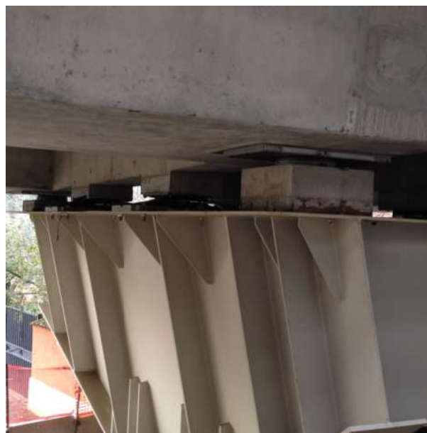
Figura 14 – Dispositivi trasversali Viadotto Dell'Osa
