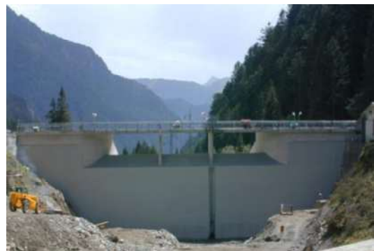
Figura 13 –Diga Ponte dell'Acqua 2001
