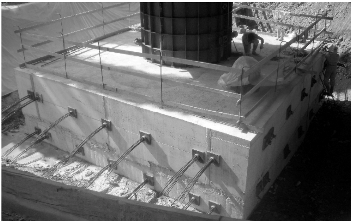
Figura 5 – Intervento di adeguamento quasi ultimato sul plinto tipo
