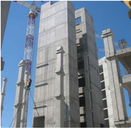
Figura 18 - Vista pilastri e muri vani scala
