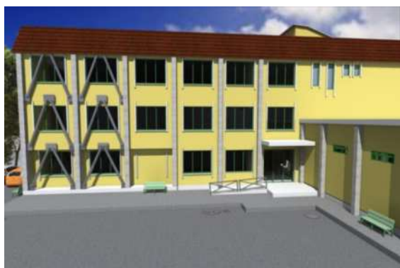
Figura 6- Render -Prospetto edificio dopo l'adeguamento
