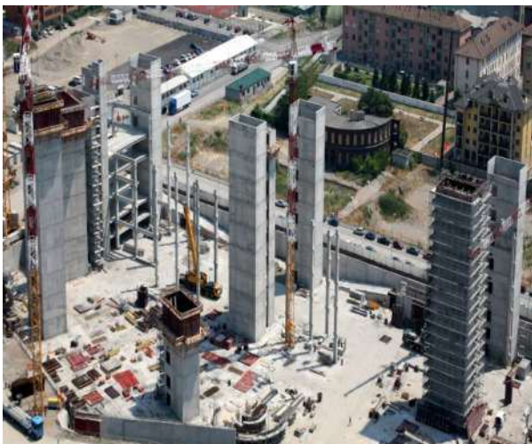
Figura 19 - Esecuzione strutture verticali in opera
