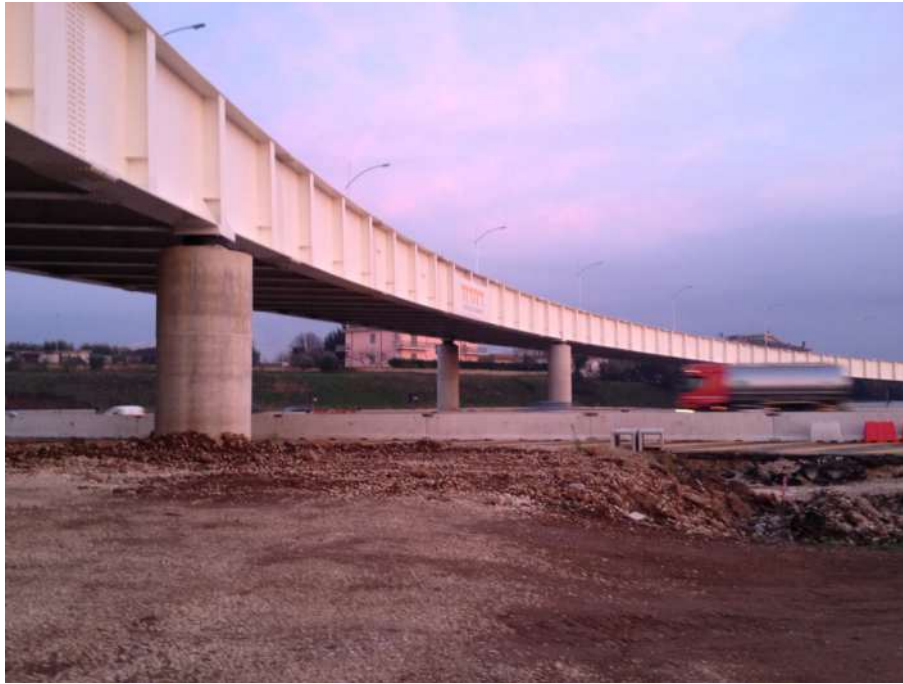
Figura 15 –Viadotto Rampa A sul ramo di svincolo nodo A24-GRA
