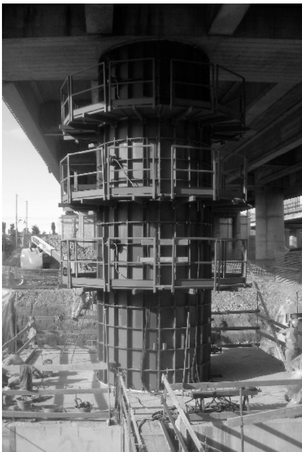
Figura 4 – Il cassero per il getto integrativo delle pile circolari
