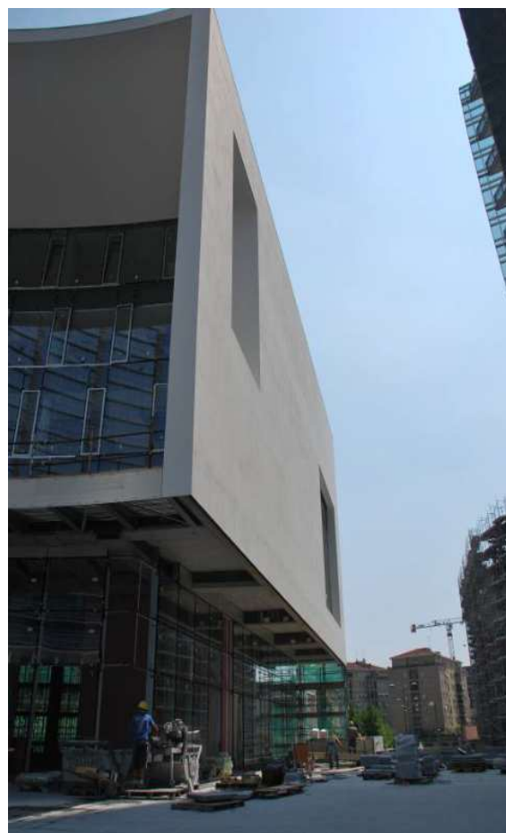
Figura 31 - Vista d'insieme della facciata est
