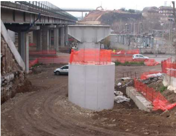
Figura 6 – Fusti pila con pulvino metallico prefabbricato
