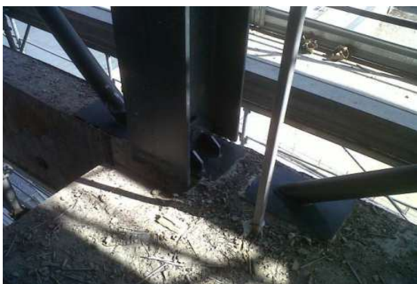
Figura 29 - Piastre predisposte nelle travi PREM per il fissaggio dei profilati in carpenteria metallica
