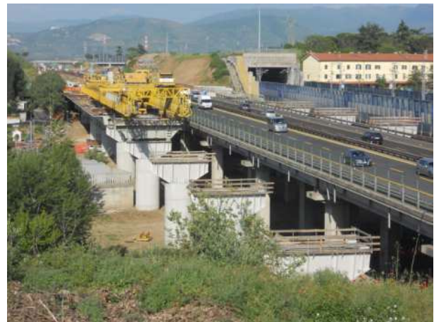
Figura 5 – Viadotto dell'Osa in fase costruttiva di varo delle travi
