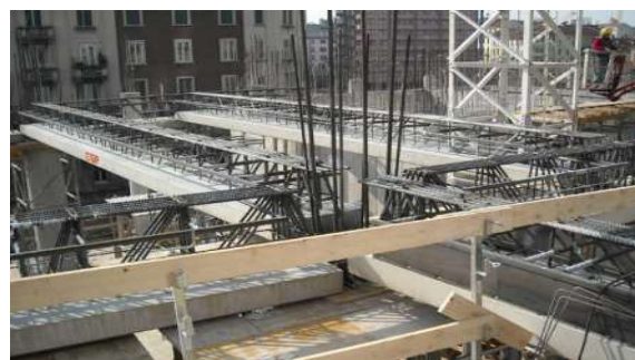
Figura 23 - Nodo trave-pilastro a quattro vie
