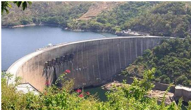
Figura 7 – Vista da valle della diga di Kariba scelta come riferimento per la valutazione degli effetti della reazione alcali-aggregato sul comportamento strutturale dell'opera (Valencia, 2011)
