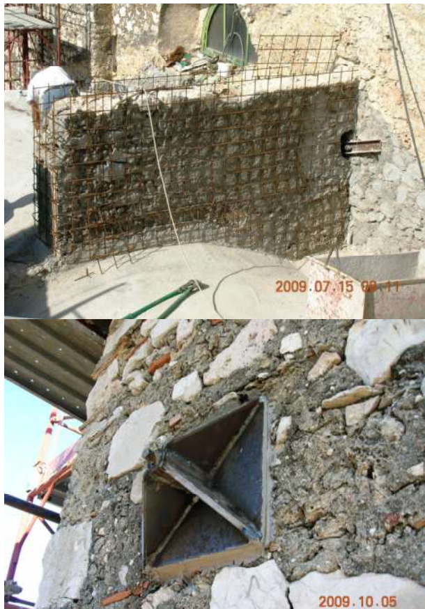
Figure 8-9. Interventi di consolidamento delle murature
