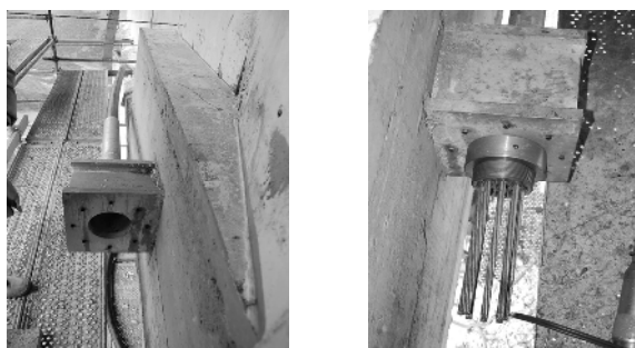
Figura 13.b - 2 Cavi esterni - traversa di contrasto in acciaio
