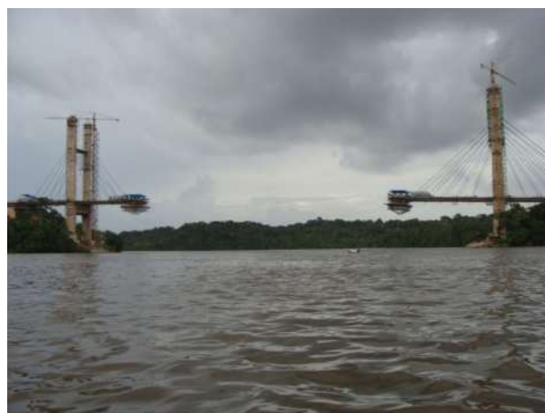
Fig. 10- I due piloni con l'avanzamento degli sbalzi al febbraio 2011
