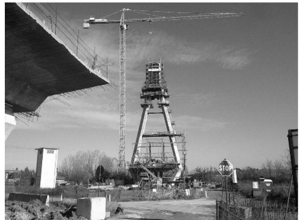
Fig. 12 Completamento dell'antenna e montaggio dei carri varo
