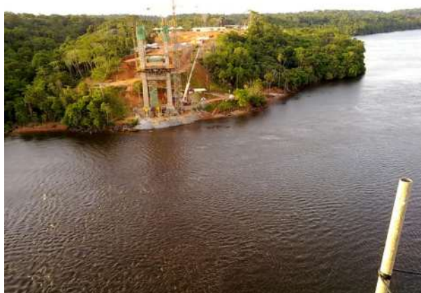
Fig. 7 - Vista del pilone nord lato GF
