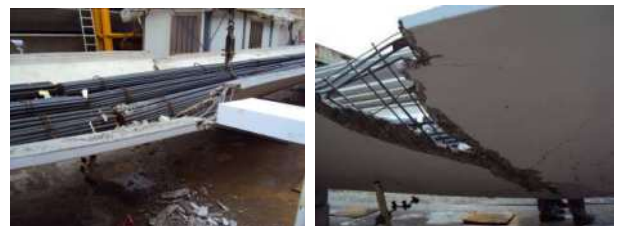
Figura 10 – Particolari della rottura del tegolo 1
