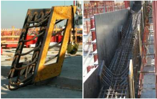
Figura 13 – Sistema di barre con boccole da inserire nel getto dell'arco centrale e a cui connettere le armature degli archi degli spalti
