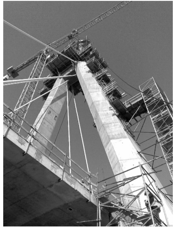
Fig. 13a e 13b Installazione dei primi stralli
