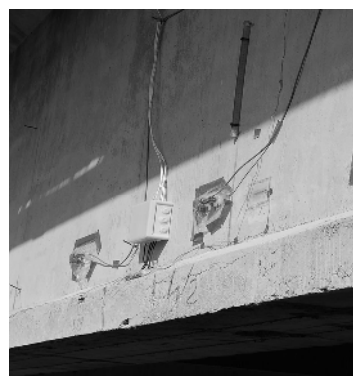
Figura 16 - Estensimetri incollati sulla superficie della trave
