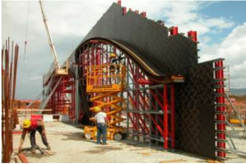
Figura 7 – Archi radiali: fase di montaggio dei casseri
