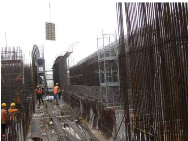
Figura 15 – Montaggio delle armature in zona gallerie.
