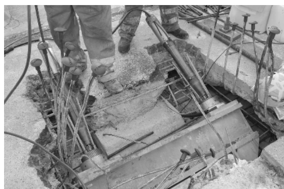
Figura 15 - Tesatura dei cavi e cella di carico
