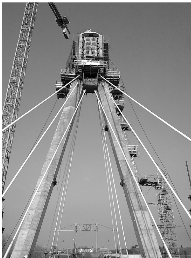
Fig. 15 Stato della costruzione nel marzo 2011
