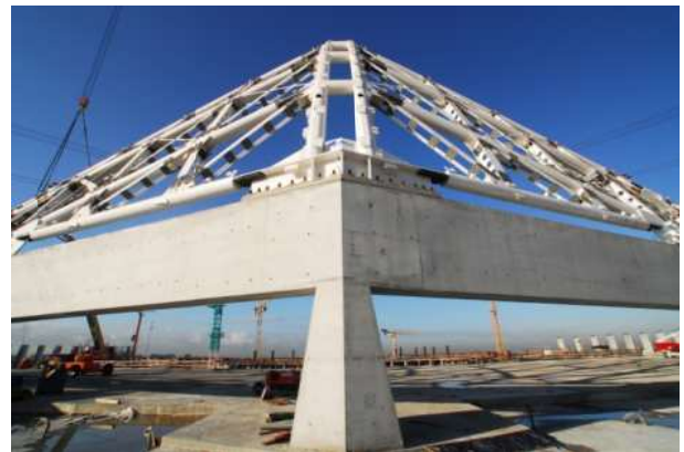
Figura 15 – Pilastro di sagoma poligonale e sezione variabile su cui grava il montante della copertura.
