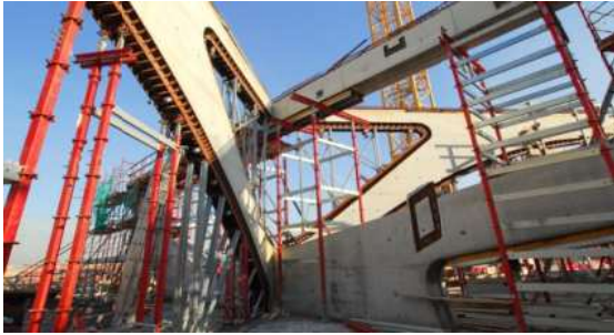
Figura 12 – Archi centrale: intersezione con gli archi degli spalti
