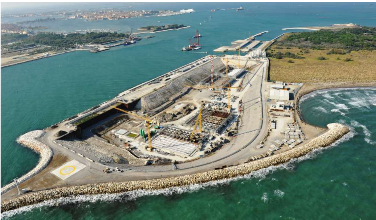
Figura 6 – Porto rifugio lato mare – configurazione provvisoria – bacino di prefabbricazione dei cassoni di barriera.
