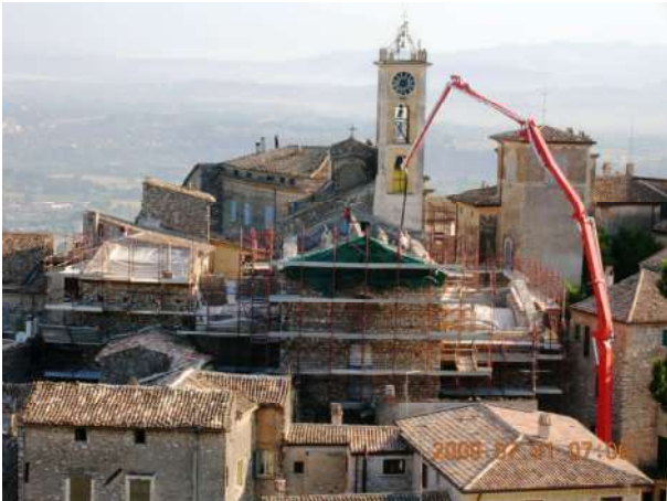
Figura 1. Vista cantiere e aree di intervento
