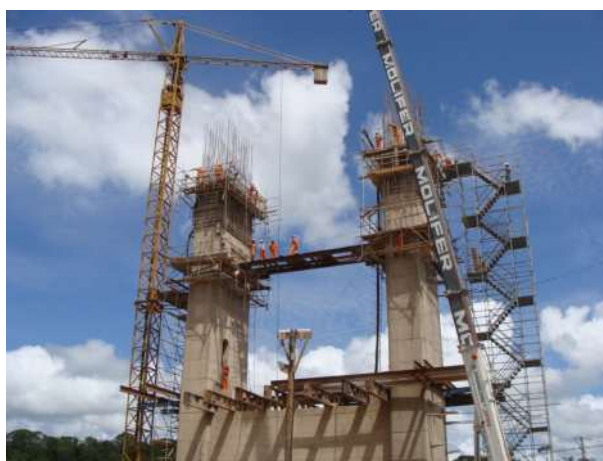
Figure 6 - Inizio della costruzione dei fusti in riva nord
