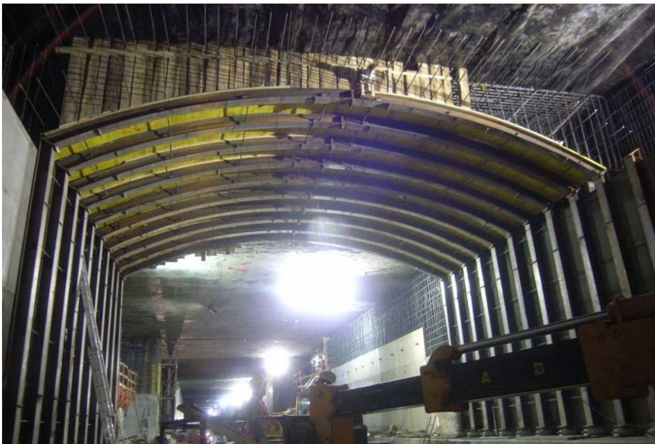
Fig. 15 – Centine a sostegno del cassero dello scatolare
