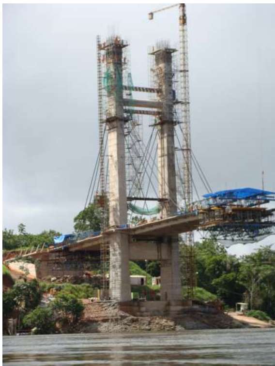
Fig. 9 - Impalcato a sbalzo sul lato sud
