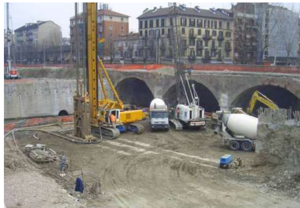
Fig. 13 – Lavorazioni dell'isola lato Torino
