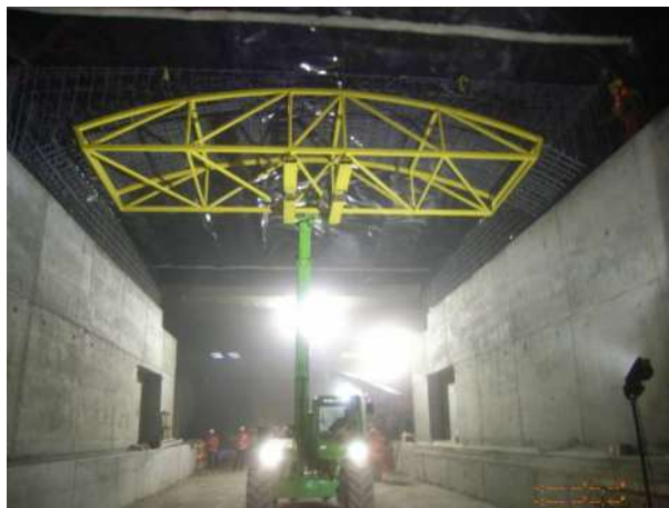
Fig. 14 – Sollevamento gabbia preassemblata
