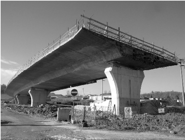
Fig. 9 Il viadotto ovest completato, in attesa del collegamento con l'impalcato strallato
