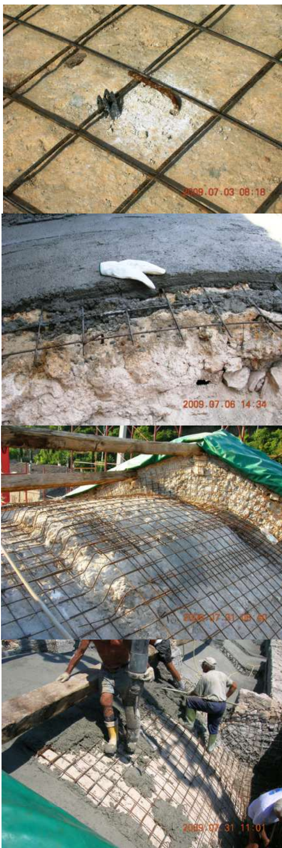
Figure 2-7. Interventi di consolidamento delle volte
