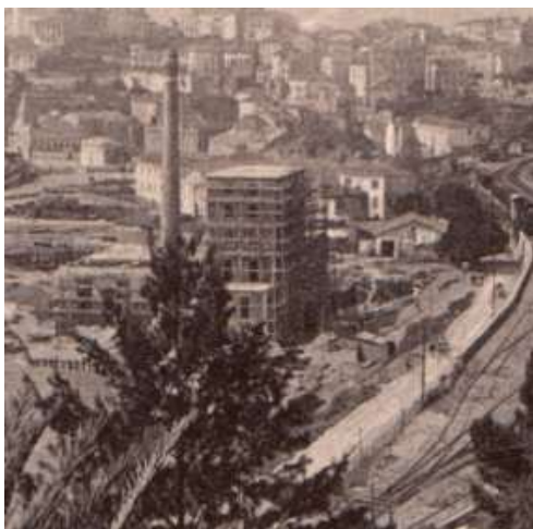
Figura 1– Prima fase di costruzione 1912
