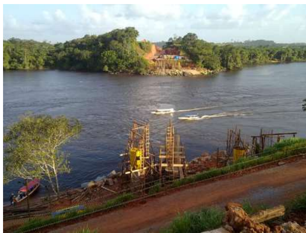
Figure 5 - Il fiume Oiapoque e la costruzione delle pile in riva sud
