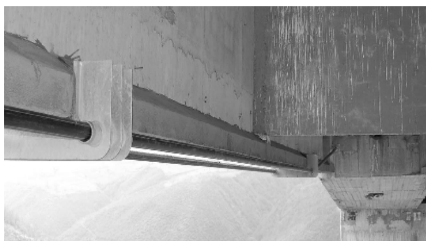
Figura 24 – Carreggiata Sud - Trave n. 2: vista dal basso
