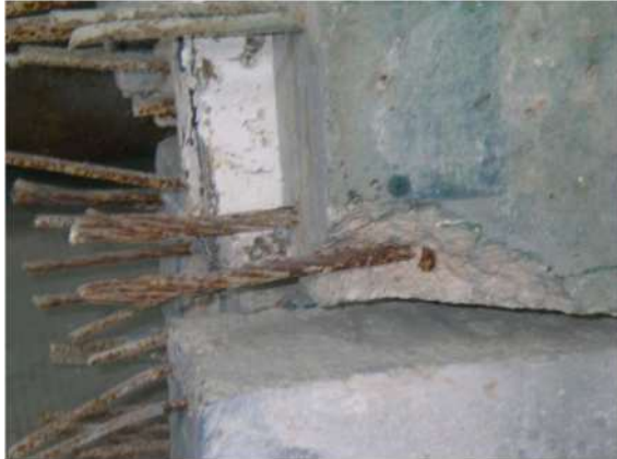
Fig.4 – Corrosione alle estremità delle travi.
