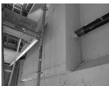
Figura 13.c - 2 Cavi esterni - contrasto in c.a.
