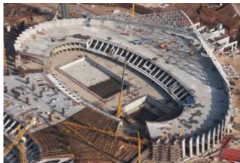
Figura 3 – Setti perimetrali: realizzazione della copertura metallica del palanuto
