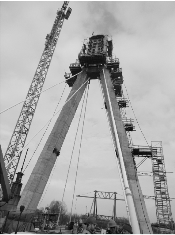
Fig. 13a e 13b Installazione dei primi stralli
