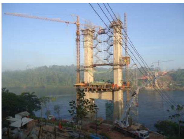
Fig. 8 - Vista dalla riva brasiliana e avanzamento dei piloni
