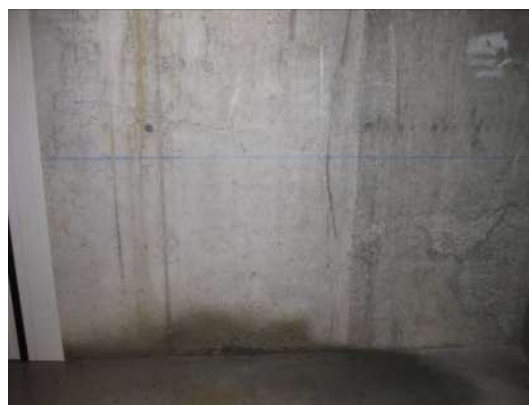
Figura 1 Calcestruzzo posato in opera senza compattazione
