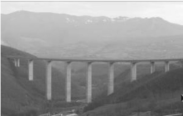
Figura 1 - Viadotto Fiumara di Tito
