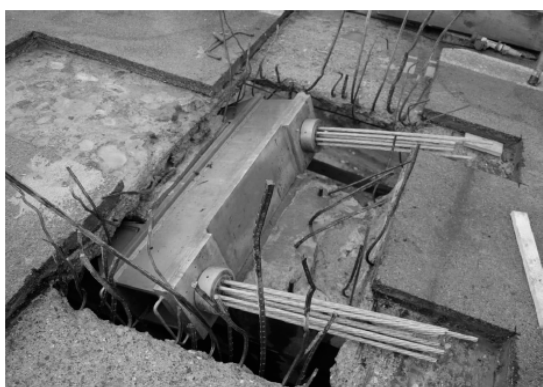
Figura 13.a - 4 Cavi esterni - ancoraggio in soletta
