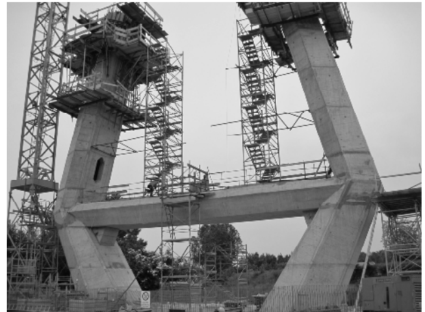
Fig. 11 Avanzamento della costruzione dell'antenna
