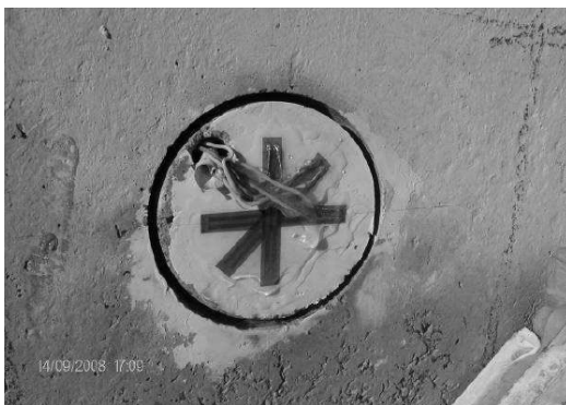
Figura 7 - Prova di rilascio sul calcestruzzo
