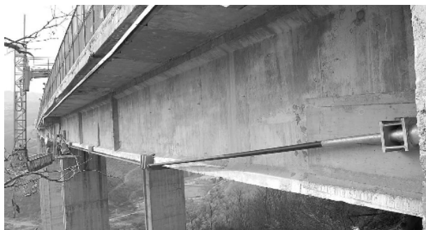
Figura 23 – Carreggiata Sud - Trave n. 2: contrasto in acciaio
