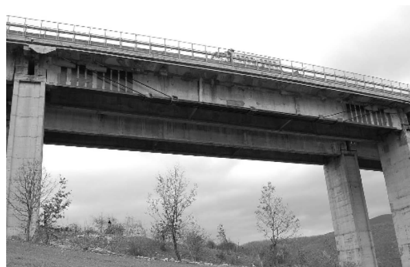
Figura 27 - Cavi esterni e rinforzo laterale dell'anima della trave
