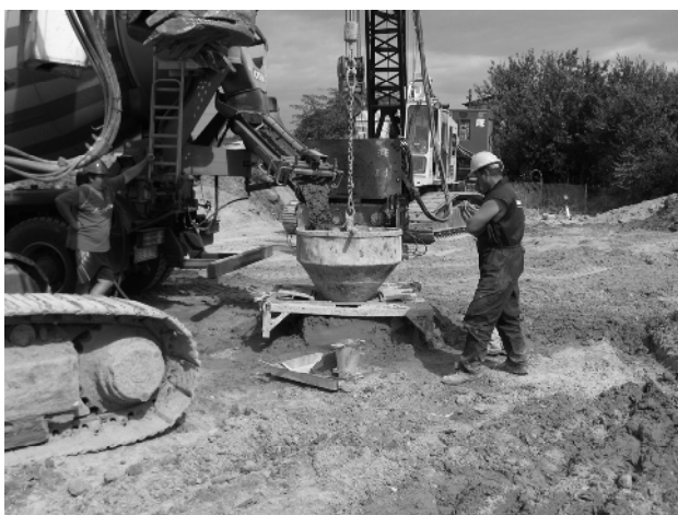
Fig. 5 Inizio della costruzione nel settembre 2009: esecuzione dei pali
