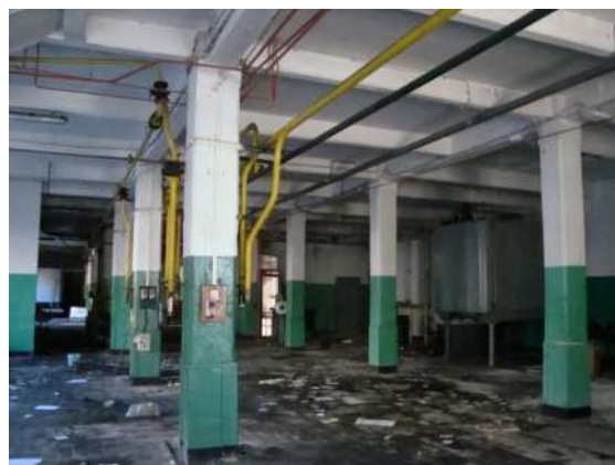
Figura 3 – Interno della parte inferiore dell'edificio.
