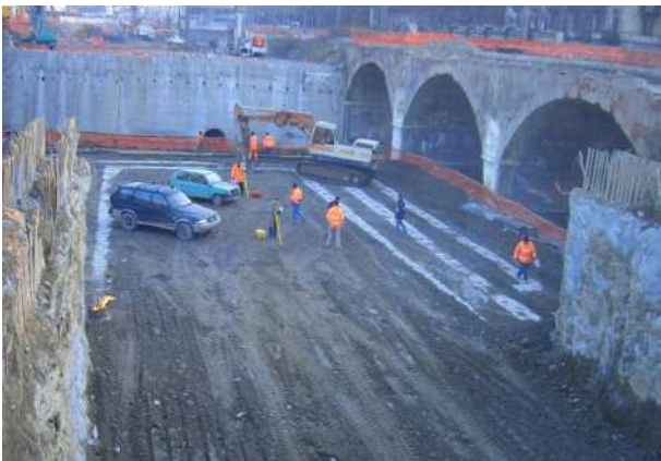
Fig. 11 – Costruzione dell'isola lato Torino
