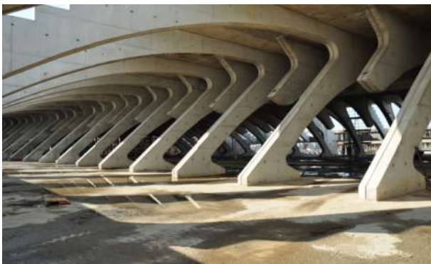
Figura 8 – Archi radiali: immagine a strutture ultimate (vista dall'alto e vista al disotto delle gradinate)
