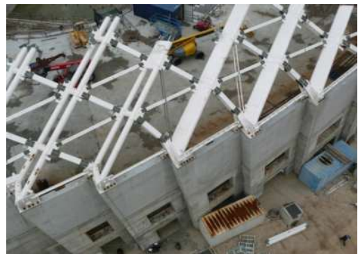
Figura 14 – Fasi di realizzazione della copertura metallica che spicca dai setti perimetrali
