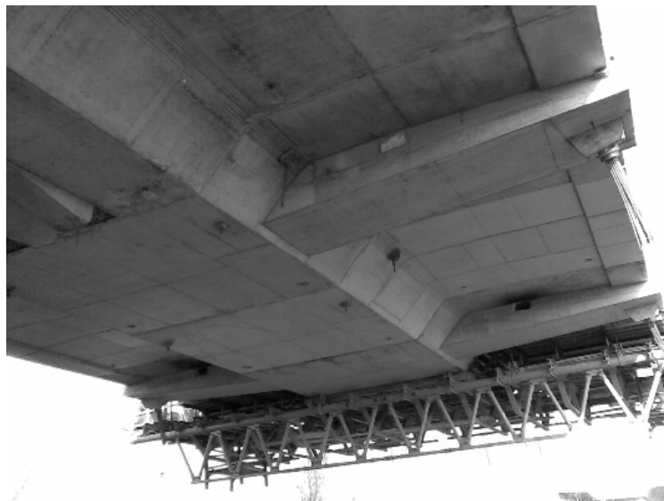
Fig. 14 L'impalcato strallato in avanzamento a sbalzo
