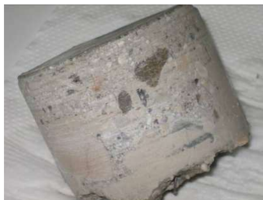
Figura 5 Dettaglio di una carota. Gli aggregati più grossi sono nella parte inferiore indicando un principio di segregazione dettato dall'eccessiva fluidità locale
