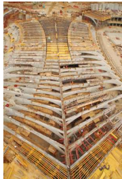
Figura 10 – Archi centrale su cui convergono gli archi delle gradinate centrali dei due edifici (visione dall'alto)
