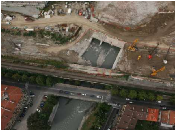
Fig. 10 – Demolizione della tombinatura del Fiume Dora
