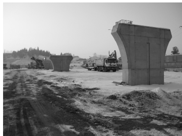
Fig. 6 Realizzazione delle pile del viadotto nel dicembre 2009
