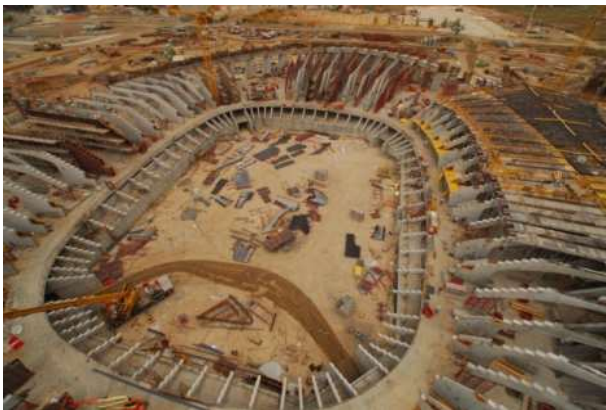
Figura 7 – Archi radiali: fase di montaggio dei casseri
