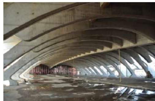
Figura 11 – Archi centrale: immagine dall'interno del foyer a strutture ultimate
