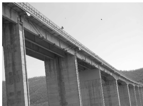
Figura 28 – Vista d'insieme dell'intervento
