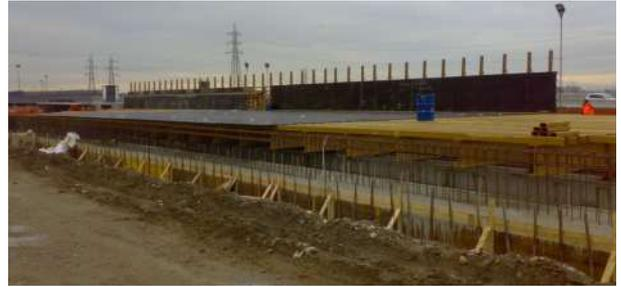
Figura 9 – Realizzazione del muretto di varo sud e disposizione dei casseri.
