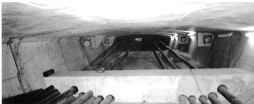
Figura 3 – Vista di impalcato a cassone con precompressione mista (ordinaria ed esterna). Si notano i cavi non aderenti ed i setti di deviazione.
