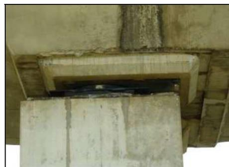
Figura 6 – Evidente spostamento dell'appoggio scorrevole su una delle pile
