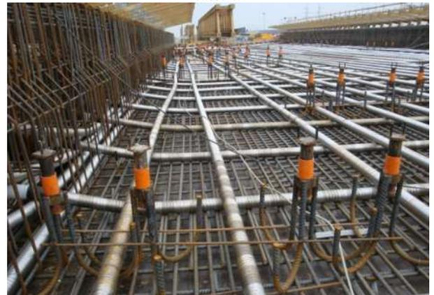
Figura 10 – La disposizione delle guaine dei cavi di precompressione con vista degli ancorotti degli avambeckhi di varo
