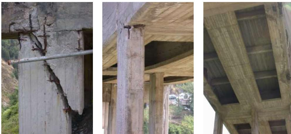
Fig. 5 Principali quadri fessurativi sulle pilastrate
