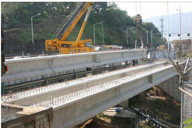
Figura 16: Posa delle travi dell'Amsa Bridge
