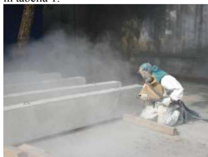
Figura 2 – Sabbatura delle travi
