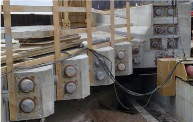
Figura 7 – Le testate dei cavi nella zona dell'angolo ottuso
