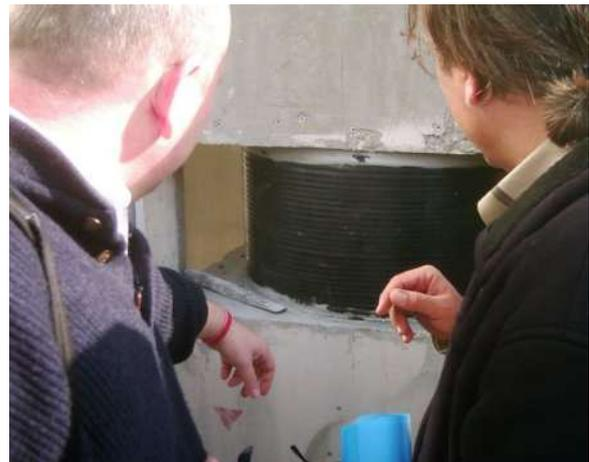
Figura 12 – Dettaglio di un LRB dopo l'installazione
