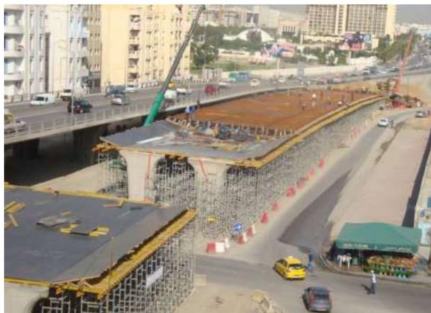
Figura 4 – Il viadotto OA2 in fase di costruzione
