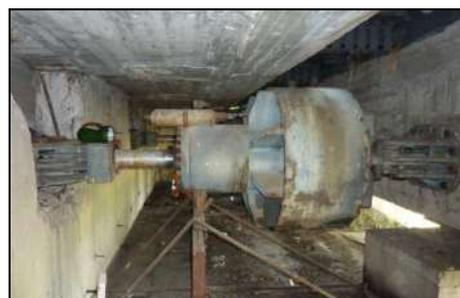
Figura 4 – Spalle di monte: dissipatori in completa estensione
