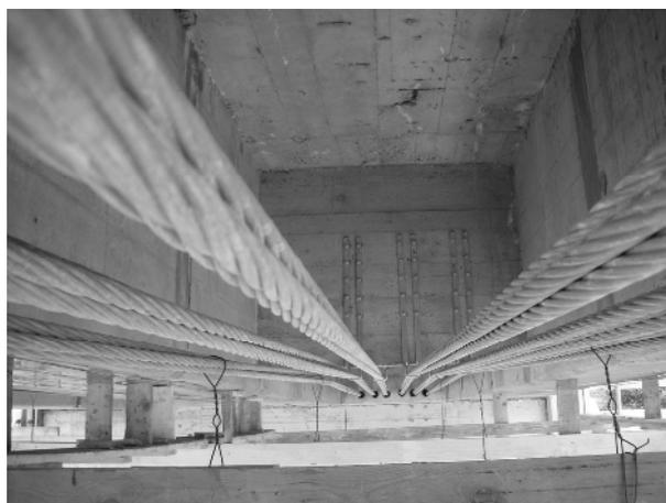
Figura 3 – Cavi di precompressione zincati
