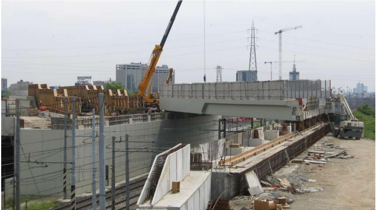
*Figura 14 – Il primo solettone è stato traslato, il secondo e pronto per il varo*
