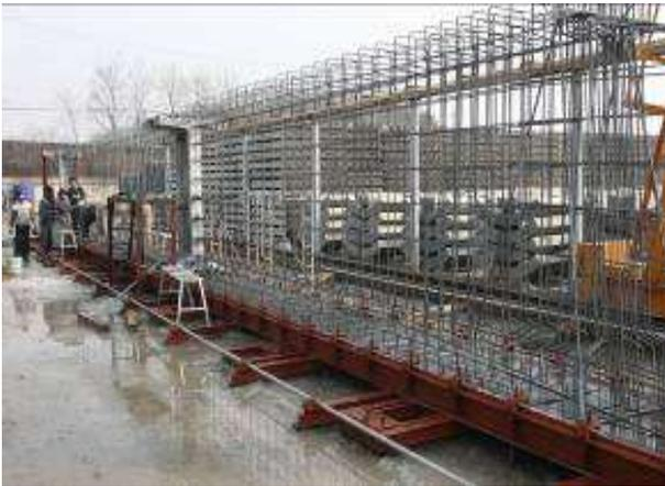
Figura 2: Armatura lenta della SegBeam
