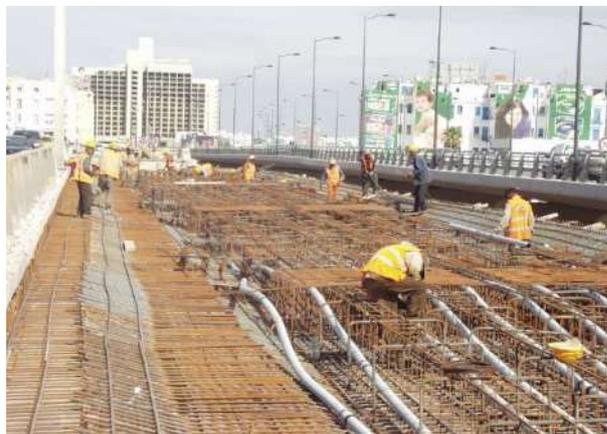
Figura 6 – Posa in opera dell'armatura lenta e delle guaine della precompressione nell'impalcato dell'OA1
