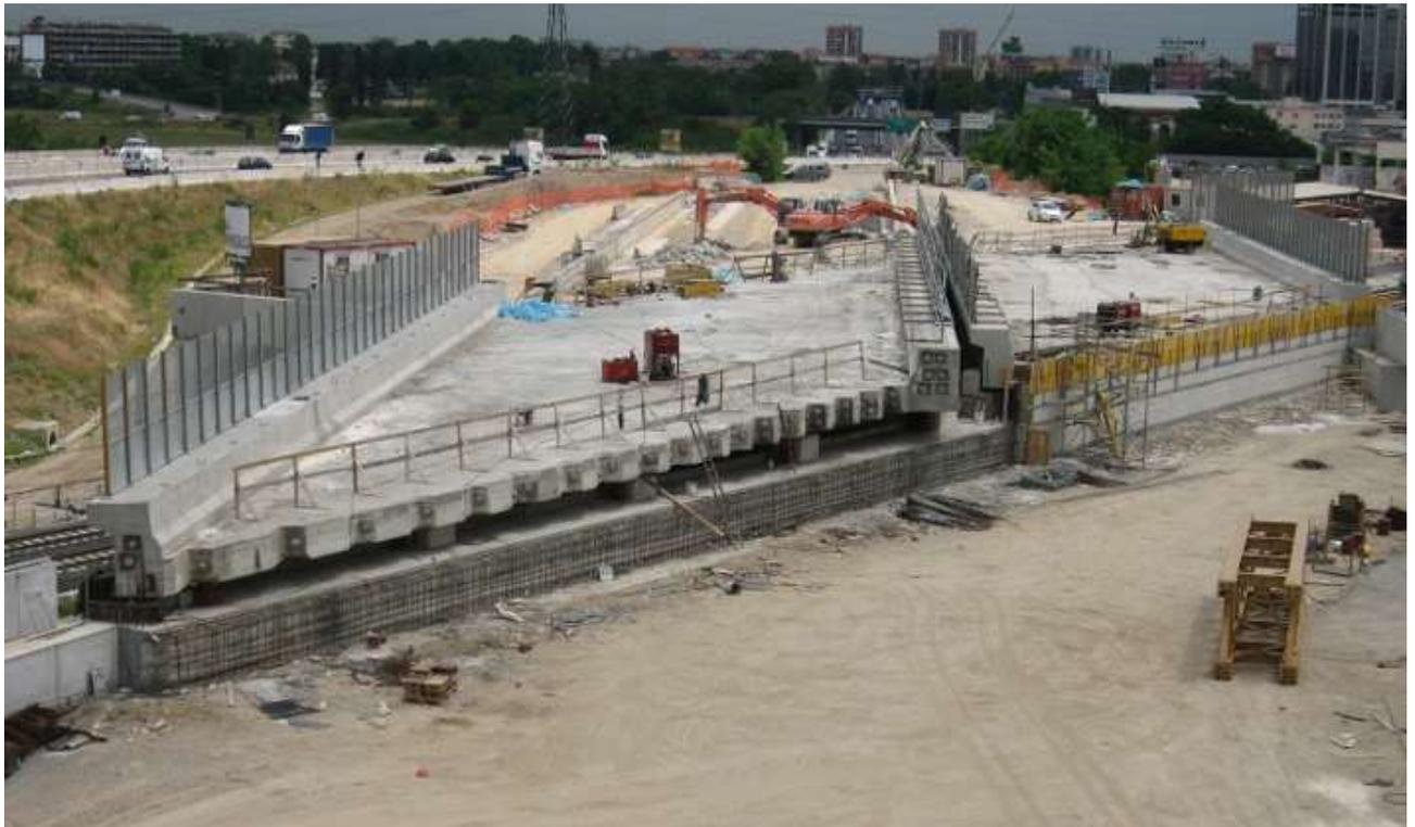
*Figura 15 – Le due strutture in posizione finale. La fortissima obliquità delle strutture è la causa del sorprendente effetto ottico per il quale le due strutture, che sono perfettamente identiche, risultano in foto molto differenti. Questo effetto si spiega facilmente se si considera che tutto il solettone di destra – quello della carreggiata Milano, visibile sullo sfondo – è molto più arretrato rispetto a quello di sinistra – carreggiata Torino.*
