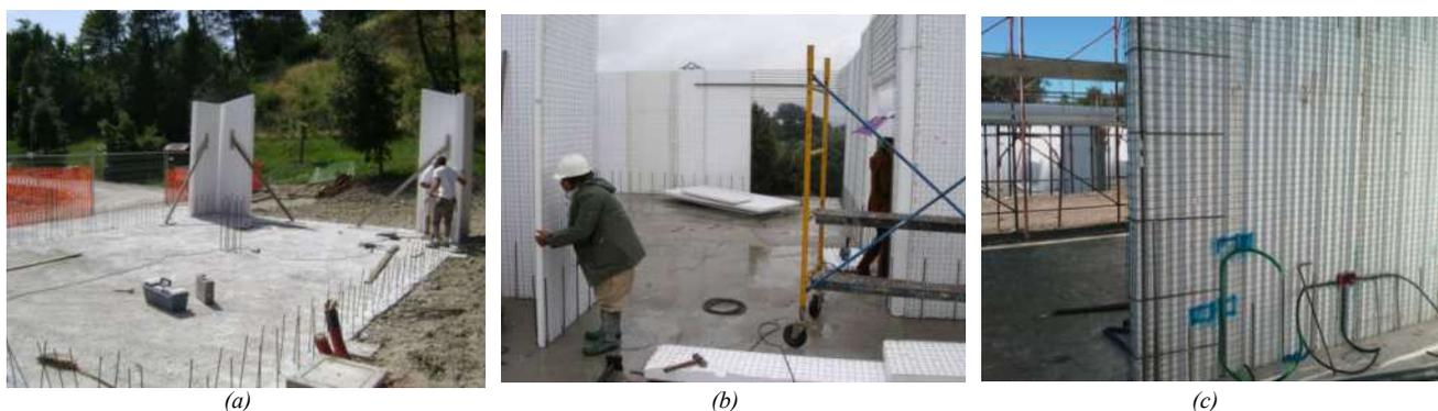
Figura 2: Esempi illustrativi relativi al tipico assemblaggio dei pannelli modulari per realizzare la parete di supporto da completare successivamente con il getto dei due strati di calcestruzzo.
