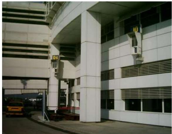
Figura 13 – Dopo il completamento dei lavori i pilastri sono stati nuovamente ricoperti dai pannelli di FRC che nascondono completamente l'intervento
