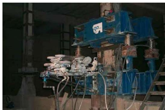
Figura 4 - Dettaglio delle morse e della sega a filo diamantato
