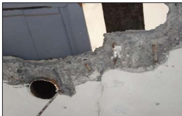
*Figura 5 – Soletta collassata dettaglio ferri a C*
