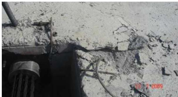
Figura 7 – Cedimento localizzato della zona di ancoraggio trefoli
