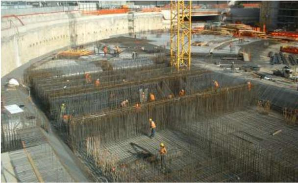
*Figura 10 Particolare della fase di realizzazione della platea*
