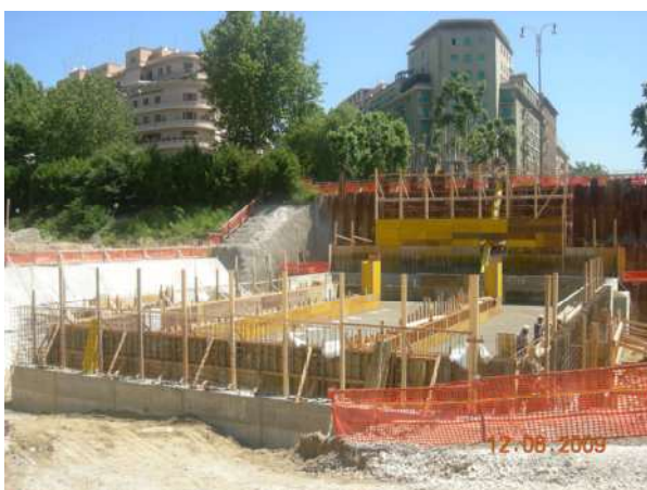
Figura 3 - Fase realizzativa della spalla mobile;
