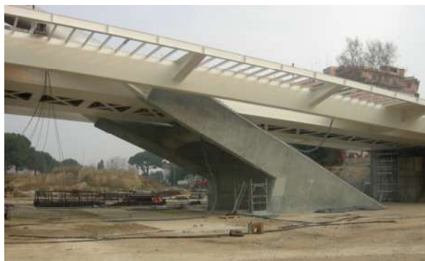
Figura 7 - Vista dei piedritti in cls di spicco dell'arco;
