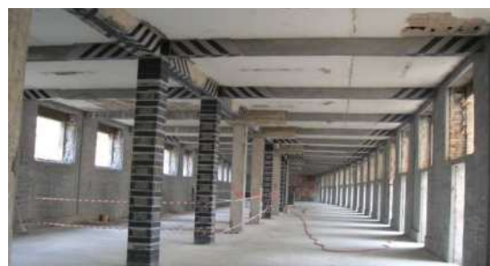
Figura 1 – Interventi di consolidamento sulla struttura
