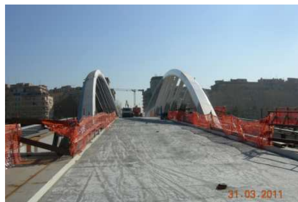
Figura 15 – Vista della soletta a getto completata;
