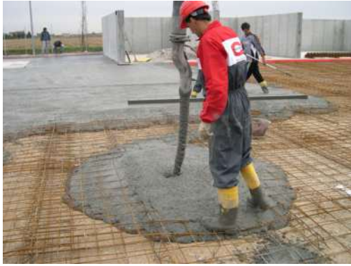
Figura 7 –Getto di Calcestruzzo a consistenza superfluida S5 con slump = 230 mm per un pavimento industriale rinforzato con rete elettrosaldata
