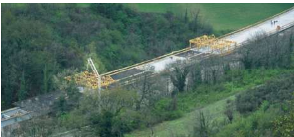
Figura 8 – Impiego di due casseri mobili per la realizzazione alternata dei getti in campata ed in appoggio
