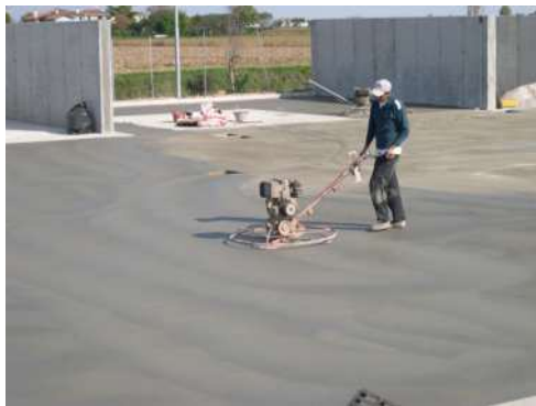
Figura 8 –Finitura con frattazzo di un pavimento industriale in calcestruzzo
