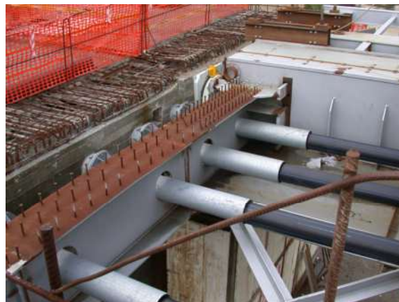
Figura 4 - Vista degli stralli di precompressione in prossimità dell'ancoraggio sulla spalla mobile;
