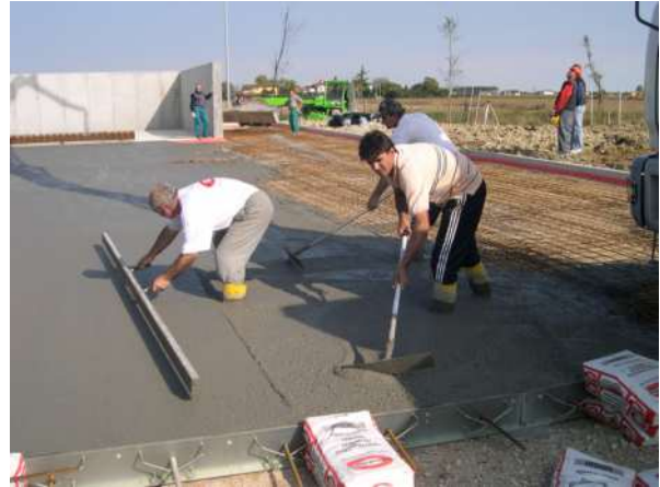
Figura 7 – Getto del calcestruzzo SRA-Super-mix per realizzare un pavimento industriale in presenza di rete elettrosaldata
