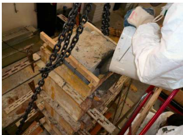
Figura 3 – Getto della camicia in HPFRC
