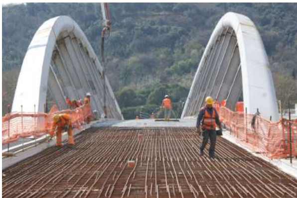
Figura 8- Vista della soletta in fase di getto;
