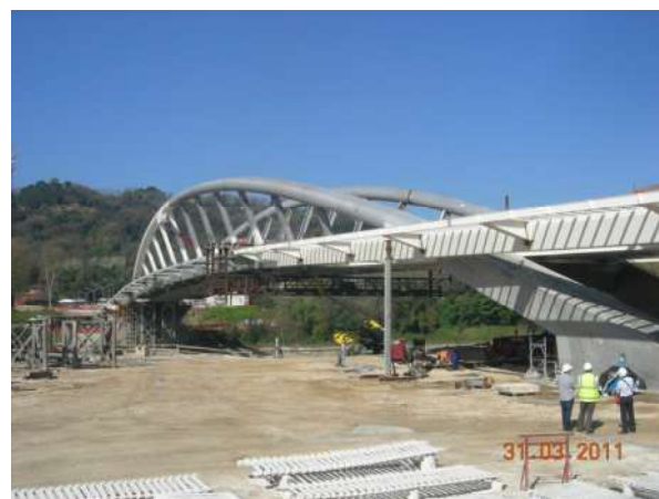
Figura 5 - Vista d'insieme del ponte ultimato;
