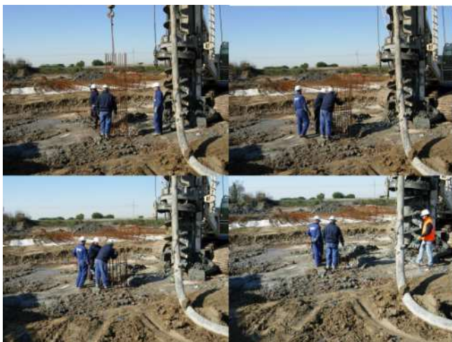
Figura 4 – Affondamento dell'ultima gabbia (la terza) nel calcestruzzo
