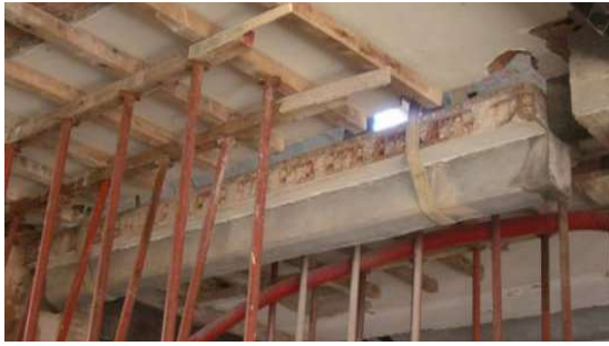
Figura 2 – Trave 2 (TM2) durante l'estrazione
