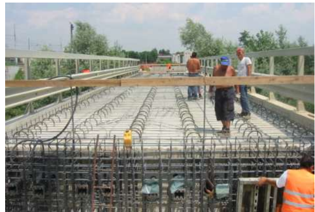
Figura 12 – Posa in opera delle armature sulla nuova soletta.
