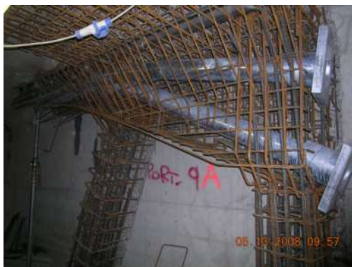
Immagine 3 – Costruzione dei setti di ancoraggio
