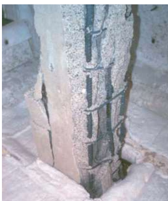
Figura 9 - Pilastro HS2-4 al termine della prova [13]
