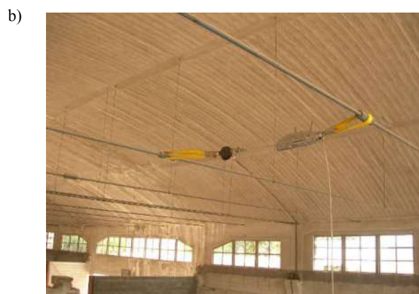
Figura 3 – Indagini sugli elementi strutturali. a) Prova di carbonatazione eseguita su di una carota prelevata da un pilastro. b) Prova semistatica per la valutazione del tiro nelle catene della copertura
