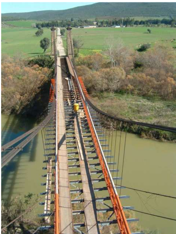
Figura 1 – Il ponte durante la riabilitazione dell'impalcato
