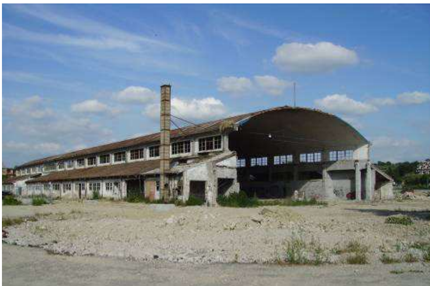
Figura 1 – Veduta generale dell'edificio nelle condizioni ante operam
