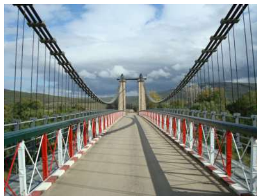
Figura 6 – Il ponte completato
