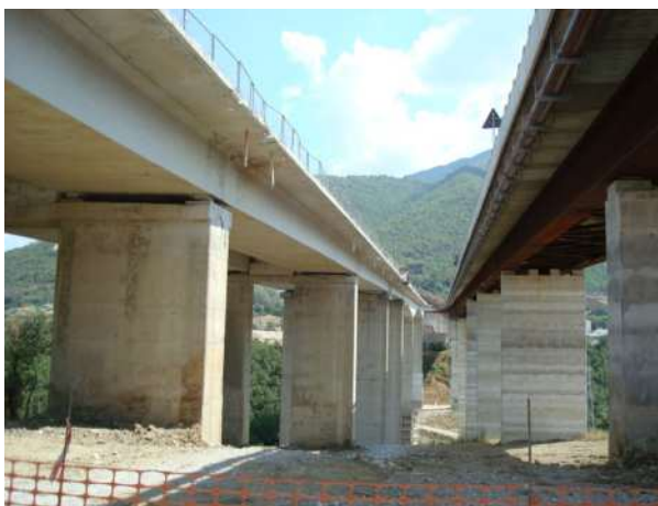
Immagine 1 – Viadotto Incoronata – Il viadotto
