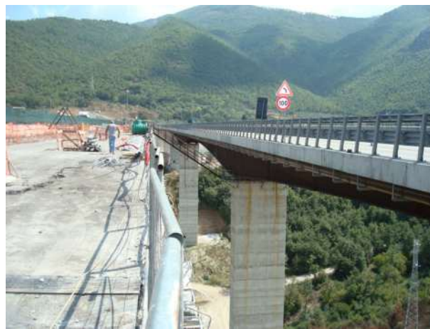
Immagine 2 – Viadotto Incoronata – Durante il lavoro
