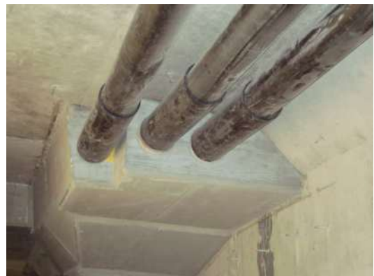
Immagine 4 – Viadotto Incoronata – Dettaglio tubi PEAD
