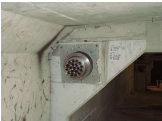
Immagine 3 – Viadotto Incoronata – Dettaglio ancoraggio
