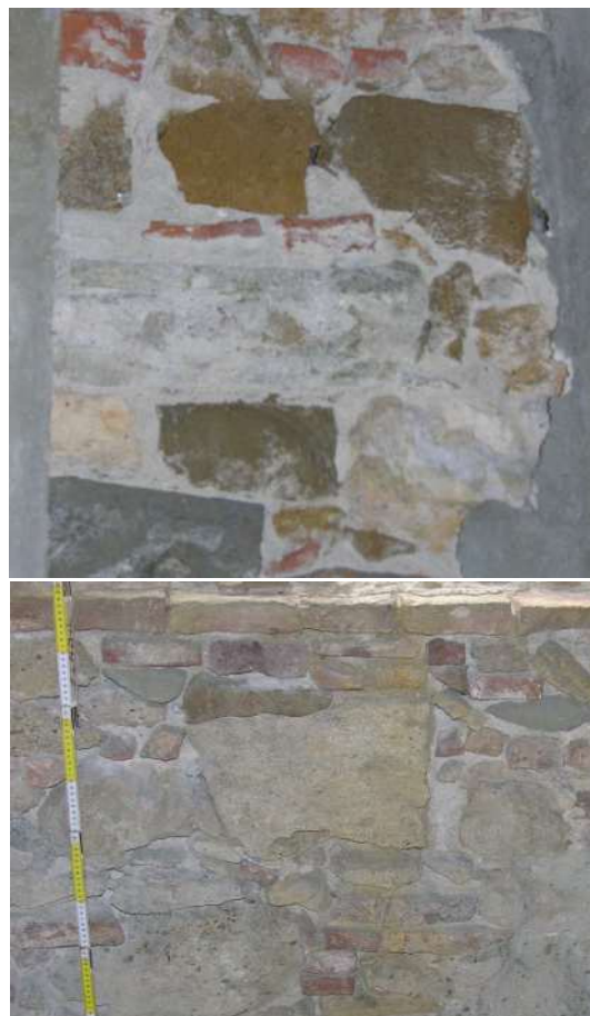
Figura 9 - Due porzioni tipiche di muratura
