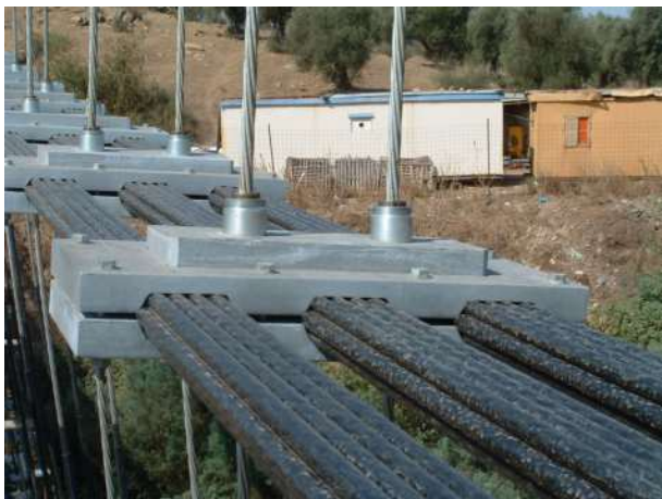
Figura 3 – Le nuove clampe, pendini e cavi di sospensione
