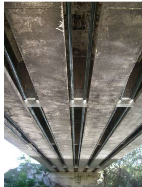
Figura 8 - Ponte di Terdoppio- vista dei cavi e selle di rinvio
