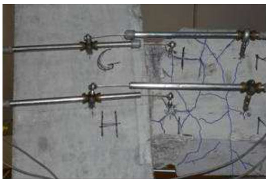
Figura 6 - Fessurazione del nodo di tipo B
