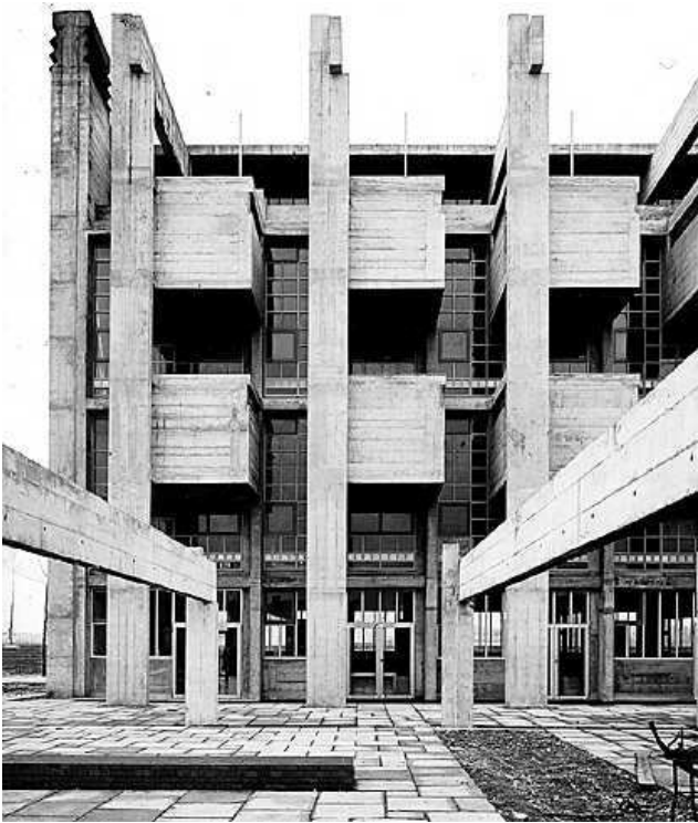
Figura 1 – Le strutture dell'Istituto Marchiondi Spagliardi [6]
