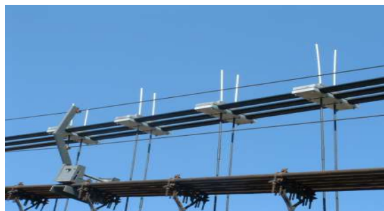
Figura 5 – Il nuovo ed il vecchio sistema di sospensione
