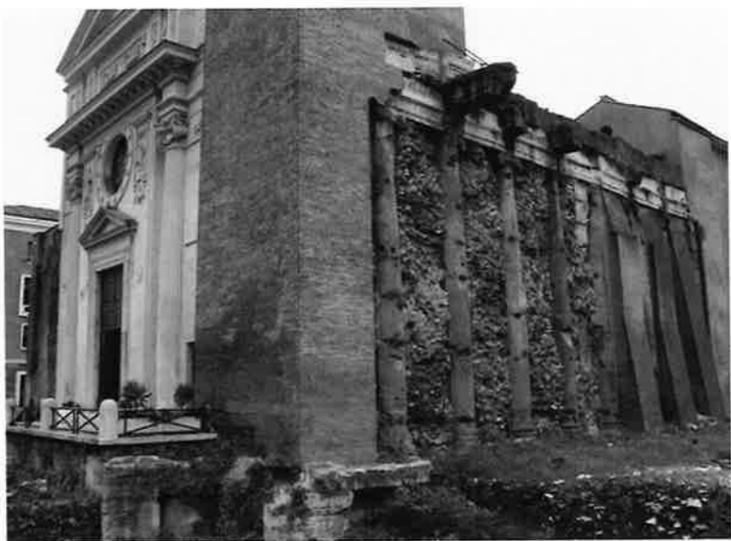
Fig. 10 — Esempio di strutture recuperate più volte per successivi utilizzi in un edificio a Roma, attualmente una chiesa
