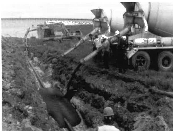
Fig. 7 - Riempimenti con calcestruzzo non strutturale realizzato con sabbie di fonderia.
