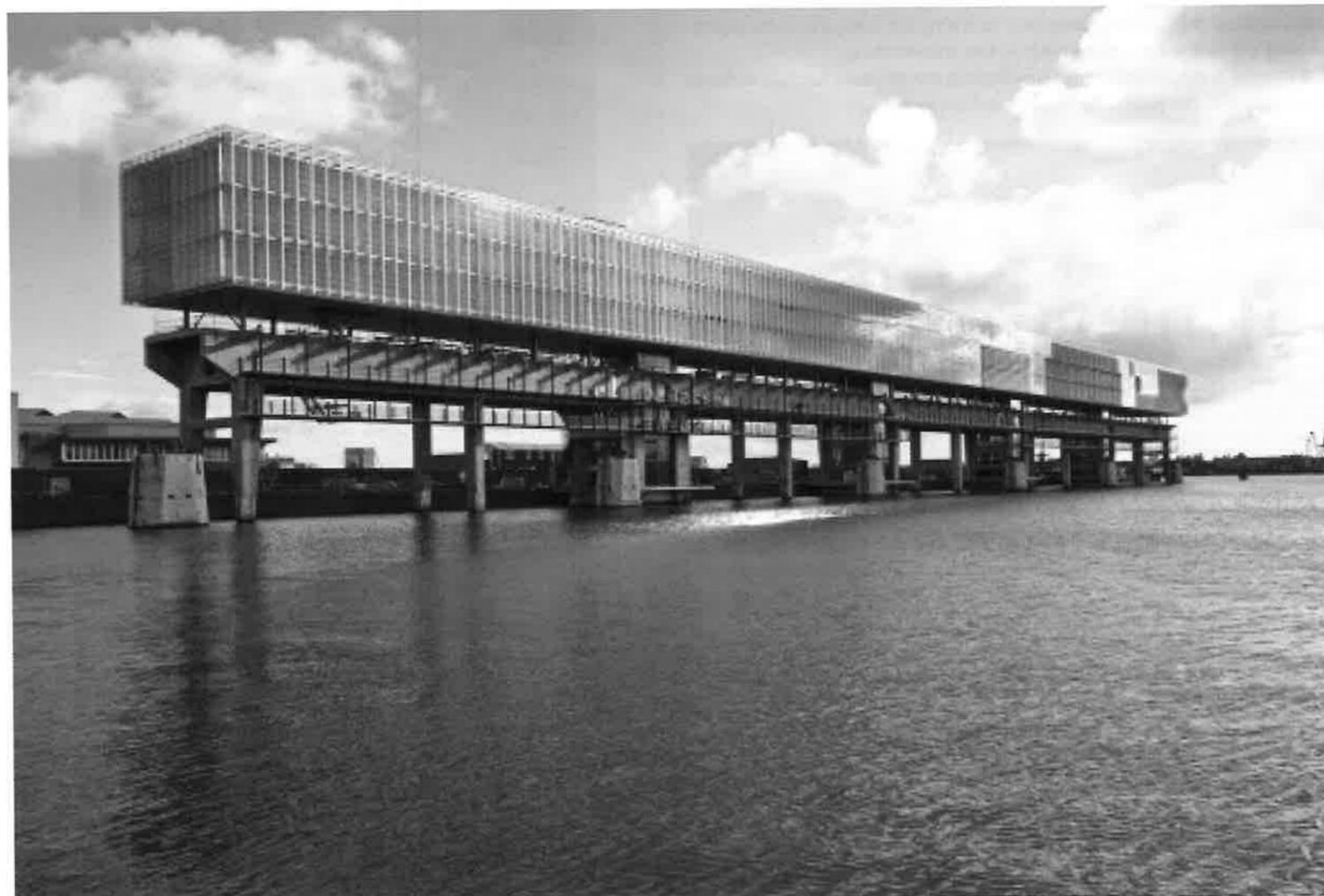
Fig. 12 — Riuso di un pontile nel porto di Amsterdam come supporto di un nuovo complesso per uffici
