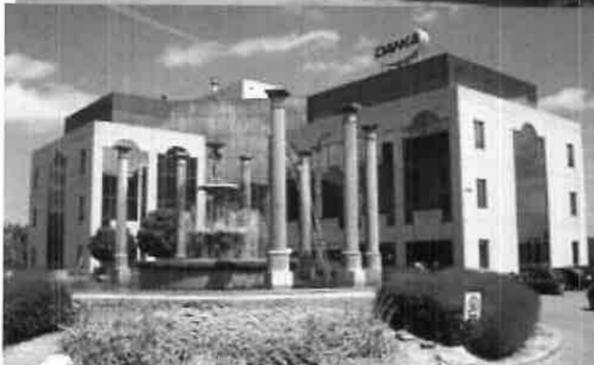
Fig. 15 - Facciate smontabili (*split-wall*), indipendenti dalle strutture portanti retrostanti
