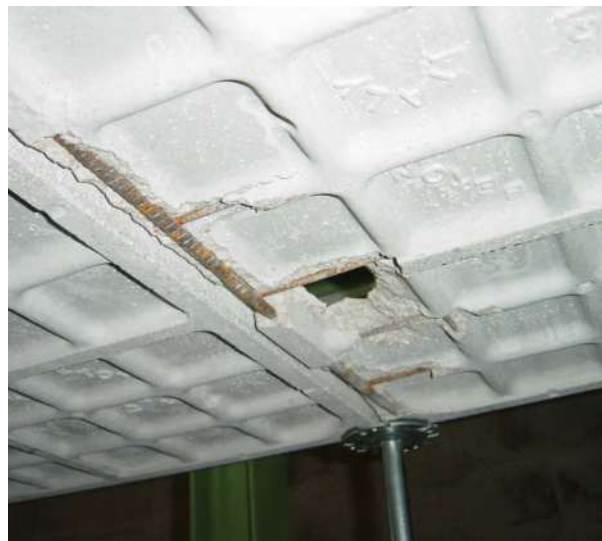
Figura 8 – Tipica rottura per fatica (vista dal basso).
