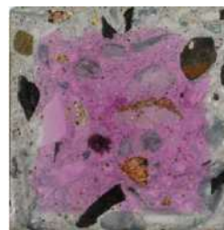
Figura 1 – Test con fenolftaleina per la determinazione della profondità di carbonatazione
