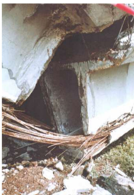
Figura 3 - Sfilamento dei cavi
