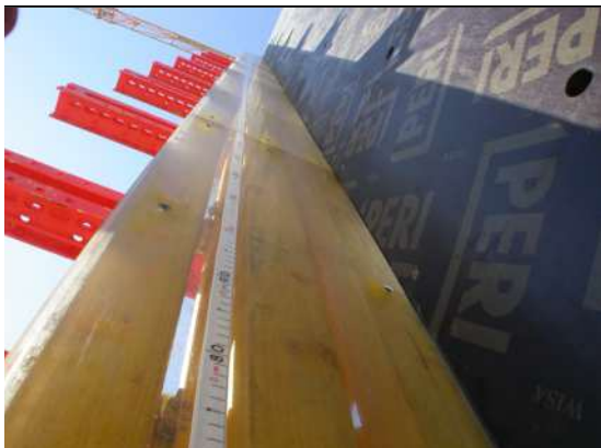
Figura 4 - Lato trasparente delle casseforme (in Plexiglas) per il controllo del riempimento.
