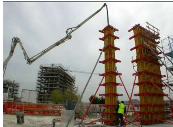
Figura 5 - Pompaggio dall'alto dell'SCC, con uso del tubo flessibile.
