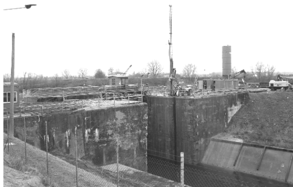
Vista del cantiere durante l'esecuzione dei pali. Rimosse tutte le precedenti sovrastrutture sono rimaste solamente le attrezzature indispensabili al regolare funzionamento della Conca
