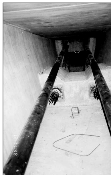
Figura 3 – Precompressione di 3 a fase a cavi esterni
