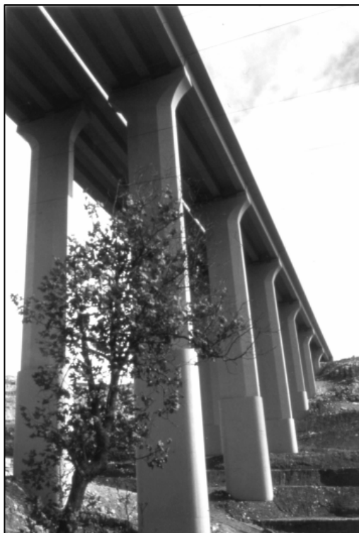
Figura 1 – Vista del viadotto Mdeirej prima dei danneggiamenti
