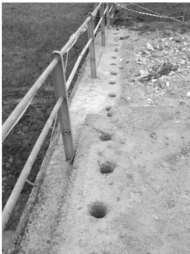
Vista della fila di pali che attraversano a tutta altezza un muro perimetrale
