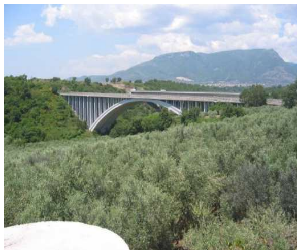
Figura 1. Il viadotto Tenza
