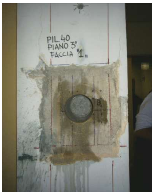
Figura 11 - Punto di estrazione di una carota di calcestruzzo
