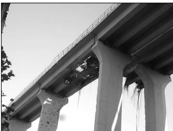
Figura 10 – Viadotto Mdeirej nord
