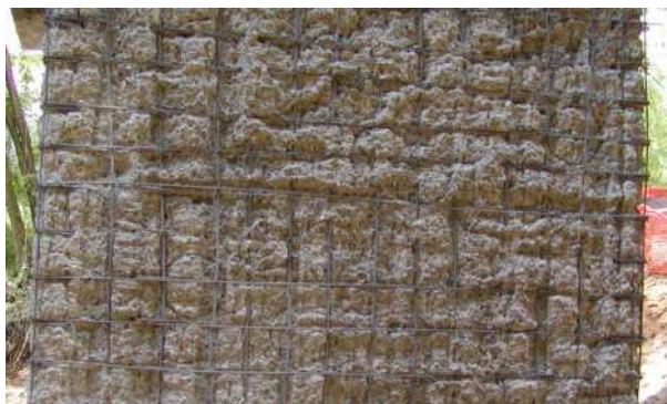
Figura 3 – Superficie di una pila ad idrodemolizione ultimata
