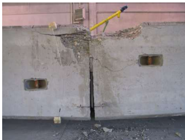
Figura 12 - Prova di pressoflessione: Sezione di giunzione al termine della prova
