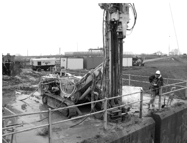
Particolare della trivella in funzione e aspetto del cantiere durante i lavori
