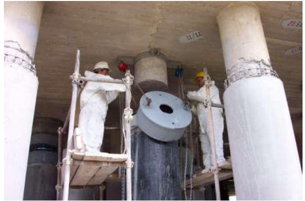
Foto 4 – Inserimento delle cuffie in acciaio in corrispondenza dei del taglio sui pilastri
