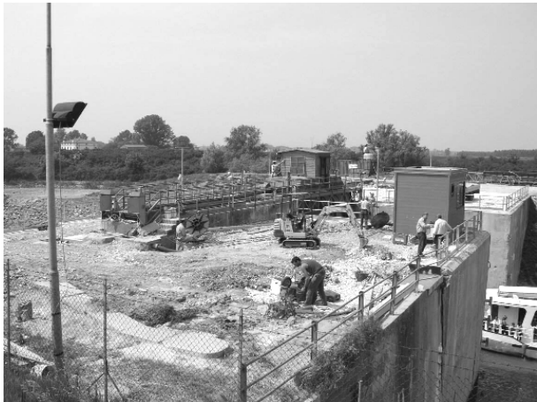
I lavori di rifacimento delle infrastrutture del piazzale
