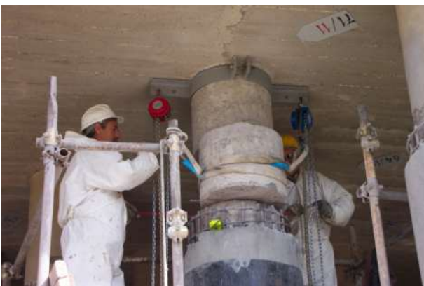
Foto 3 – Taglio della porzione superiore dei pilastri necessaria all'introduzione degli isolatori
