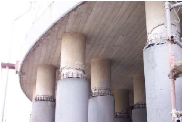
Foto 2 – Incamiciatura dei pilastri esistenti con corona in betoncino autocompattante
