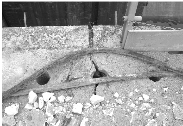
Questo palo è stato trivellato in corrispondenza di una lesione al fine di ripristinare la continuità strutturale
