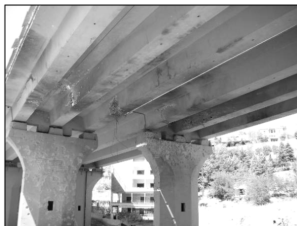
Figura 11 – Viadotto Grand Hotel
