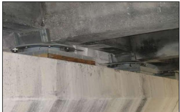
Figura 9 – Montaggio dei nuovi appoggi antisismici
