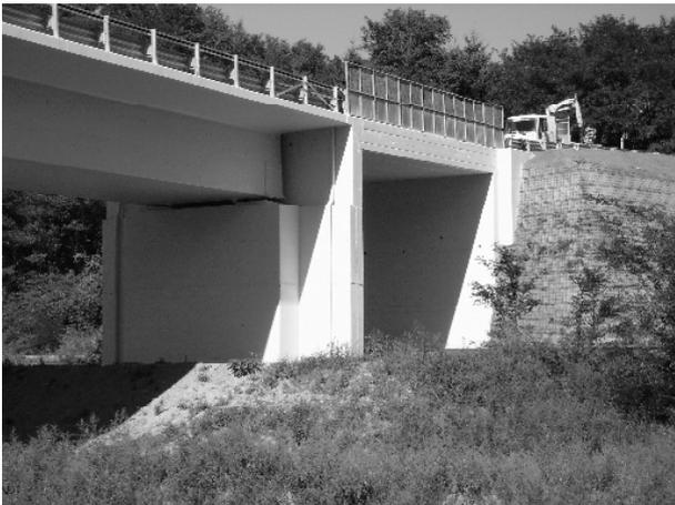
Figura 4 - Scatolare di attraversamento
