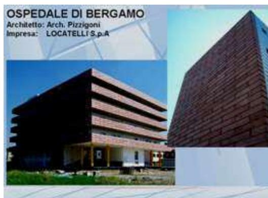
Figura 17 – Esempio di facciate in GRC
