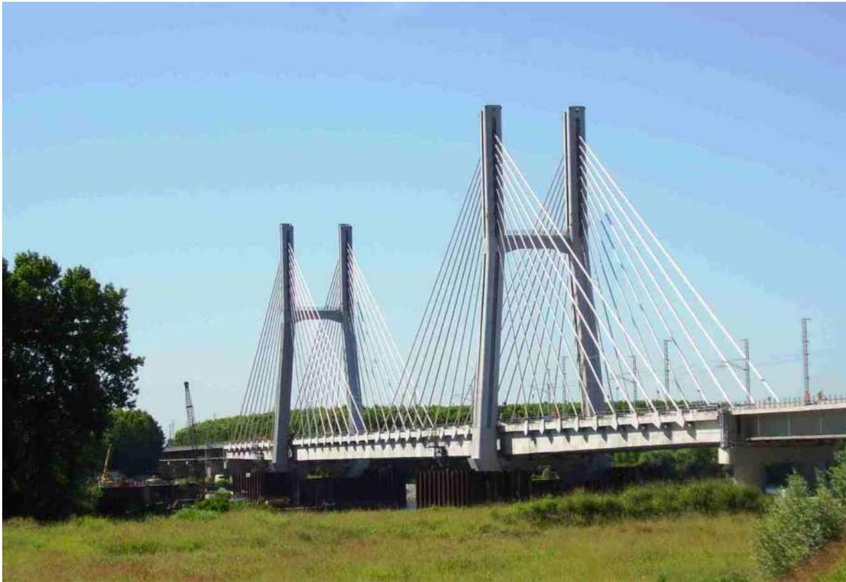
Figura 17 – Vista del ponte terminato (E' ancora presente il palancolato intorno alle fondazioni in alveo)
