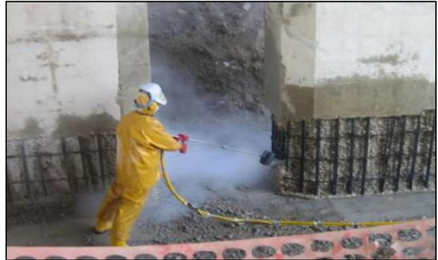
Figura 3 – Idrodemolizione delle pile
