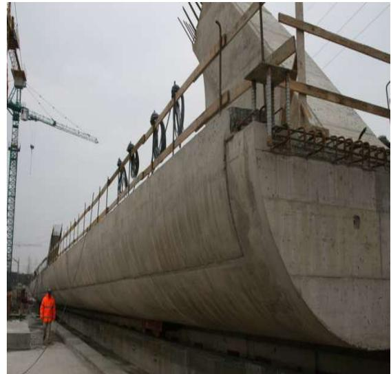
*Fig. 4 – Impalcato in posizione di spinta*
