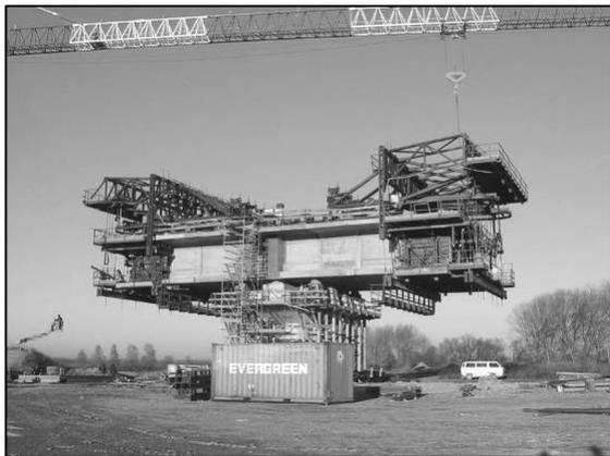
Figura 9 – Costruzione a sbalzo dell'impalcato
