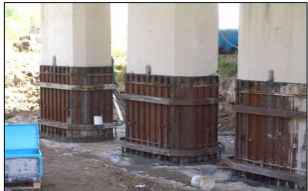
Figura 8 – Casseratura e getto di completamento di una pila
