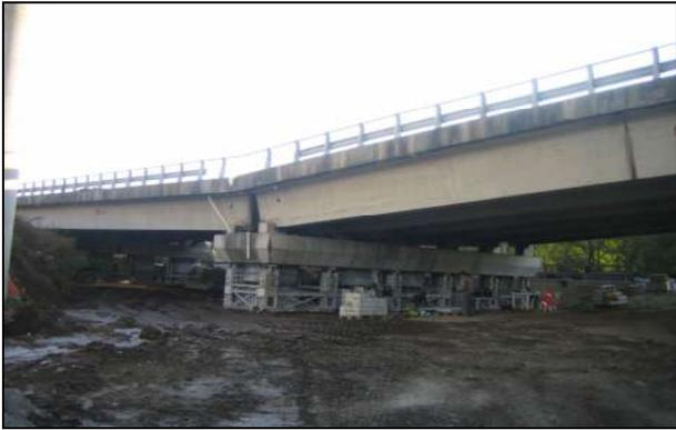
Figura 6 – Impalcato dopo l'abbassamento di una pila
