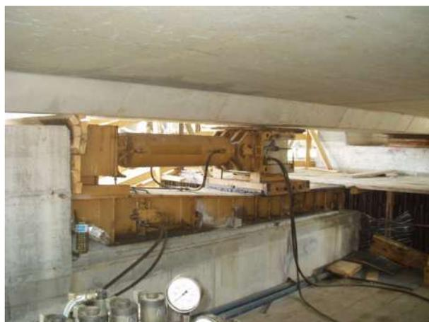
L'attrezzatura di spinta era costituita da due gruppi di sollevamento/spinta, ciascuno da 700t di forza orizzontale e 1400t di forza verticale con corsa 800mm e ciclo teorico di 6 minuti; completava l'equipaggiamento di spinta un avambecco metallico di 36m.
