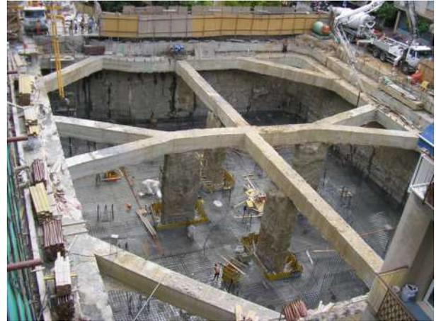
Figura 15 – Sistema di contrasto provvisorio delle paratie
