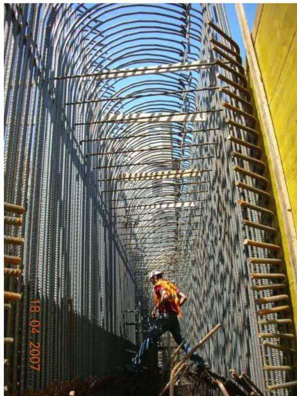
Figura 8 – Particolare delle armature della spalla
