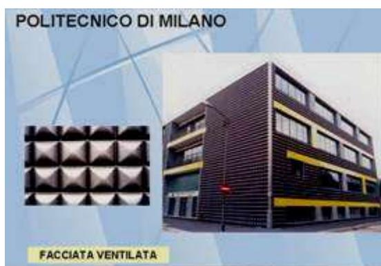
Figura 18 – Esempio di facciate in GRC
