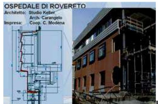
Figura 15 – Esempio di facciate in GRC
