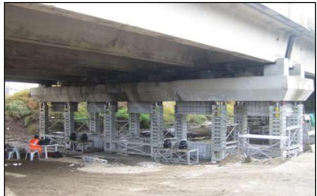
Figura 5 – Impalcato prima dell'abbassamento
