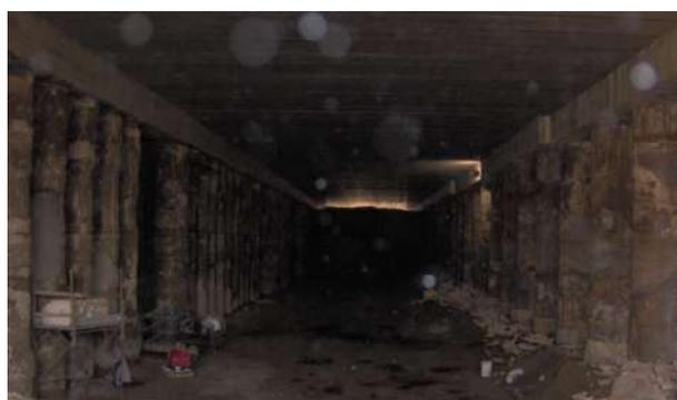
Figura 10 – Scavo in galleria sotto copertura
