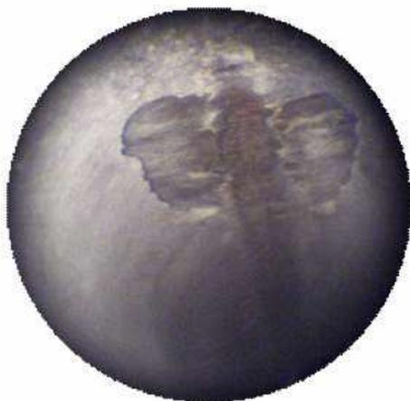
Figura 8 – Endoscopia con evidenza di vespaio in prossimità dell'interfaccia fondazione in cls – basamento in acciaio
