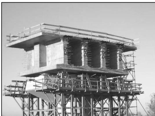
Figura 2b – Un concio testa pila in costruzione
