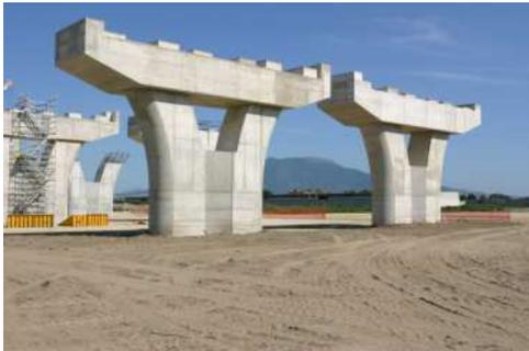
Figura 5 – Pile in fase di costruzione
