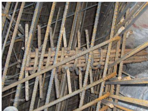
Figura 7 – Particolare delle armature di collegamento dei micropali alla zattera di fondazione della spalla del ponte
