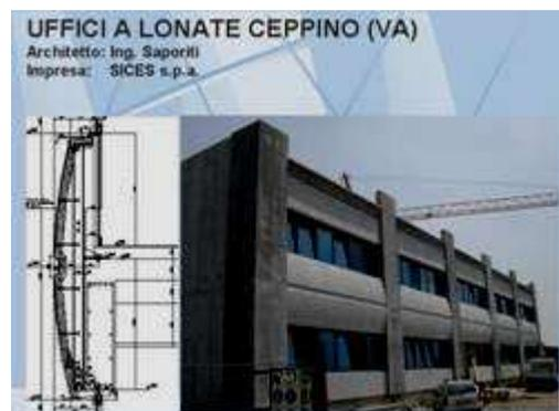
Figura 16 – Esempio di facciate in GRC
