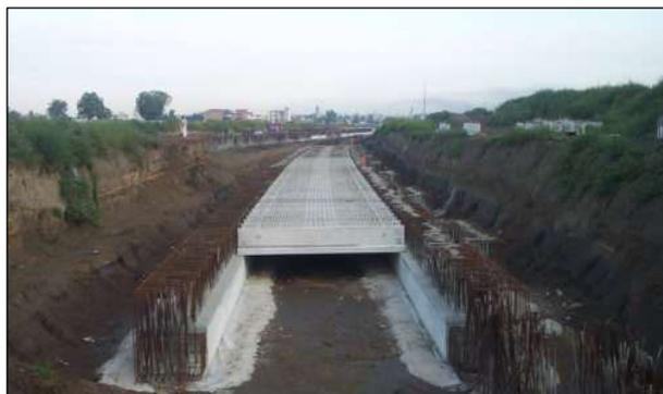
Figura 9 – Posa in opera elementi prefabbricati IBD
