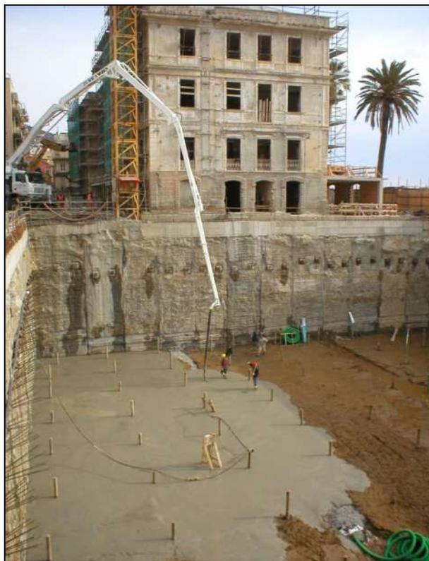
Figura 7 – Le paratie contrastate dai tiranti, a scavo completato
