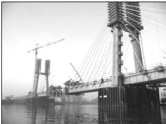
Figura 10 – costruzione dell'impalcato strallato
