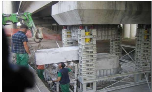
Figura 4 – Taglio delle pile e rimozione dei blocchi tagliati
