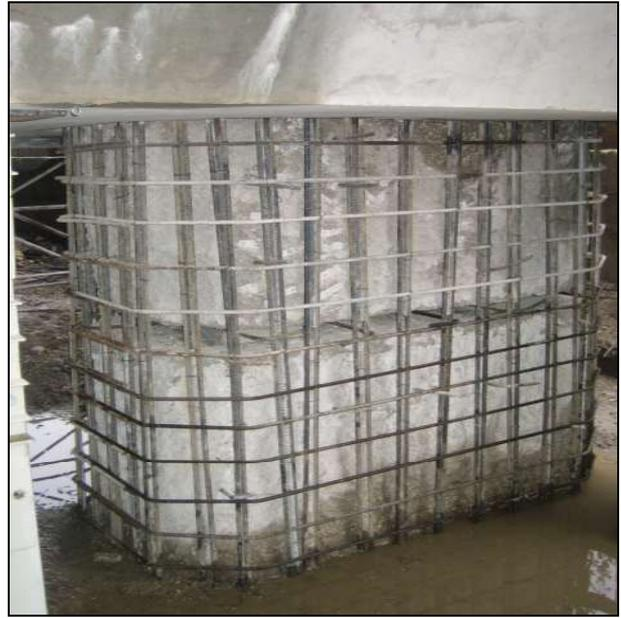
Figura 7 – Ripristino dell'armatura di una pila
