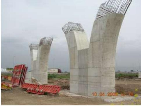
Figura 4 – Pile in fase di costruzione
