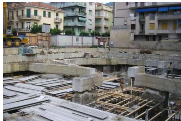
Figura 16 – Demolizione dei contrasti provvisori (taglio con filo diamantato)
