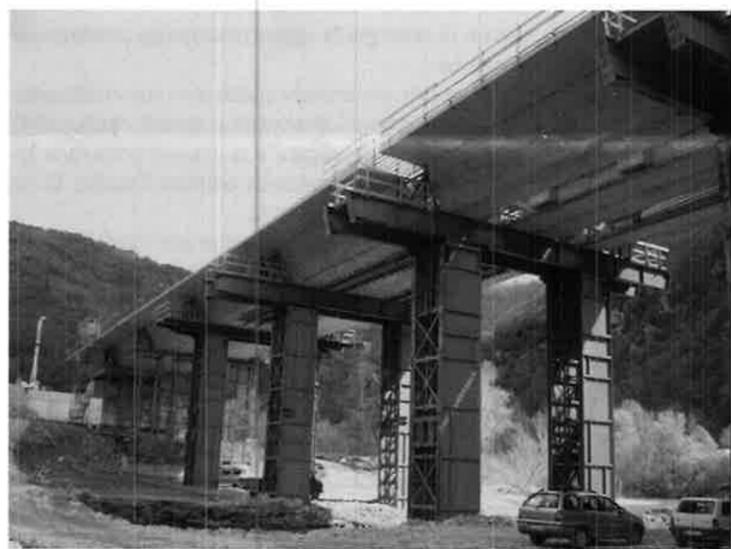
Fig. 11 - Ponte ad arco in sistema misto sul Serchio - Montaggio dei conci d'impalcato.
