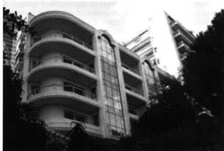
Fig. 44 - Nuovi sviluppi di rivestimento di facciate in GRC con azione fotocatalitica autopulente - Residence Saint John's Court a Montecarlo dopo la ristrutturazione.
