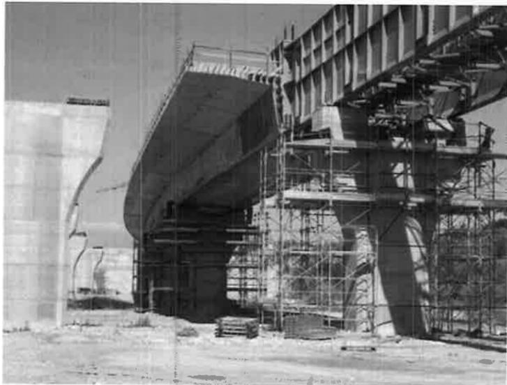
Fig. 5 - Viadotto Tanaro IV - Fase di spinta dell'impalcato con l'impiego di avambecco metallico.
