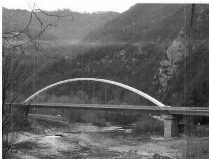
Fig. 12 - Ponte ad arco in sistema misto sul Serchio - Vista generale dell'opera.
