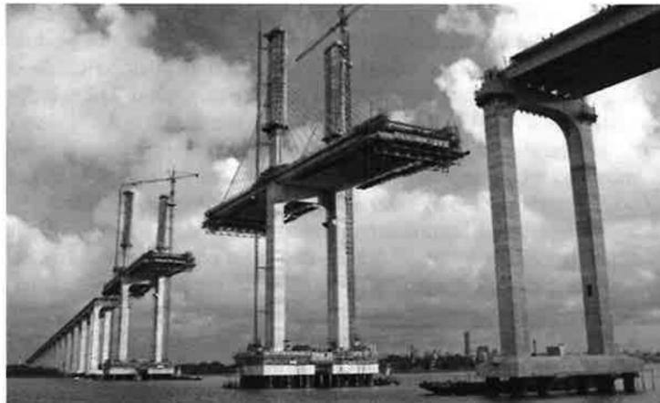
Fig. 25 - Ponte Strallato sul Rio Potengi - Fasi di costruzione dell'impalcato strallato.
