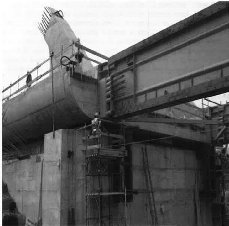
Fig. 8 - Ponte sul Savena - Impalcato ed avambecco per la spinta.
