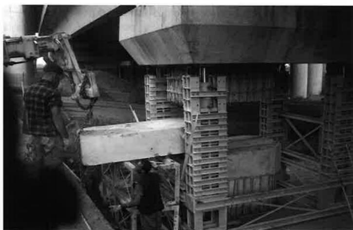
Fig. 45 - Viadotto Regi Lagni - abbassamento della livelletta stradale - Taglio delle pile e rimozione dei blocchi tagliati.
