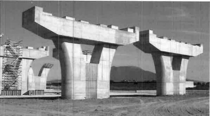
Fig. 21 - Viadotto Asse Mediano - Pile in fase di costruzione.
