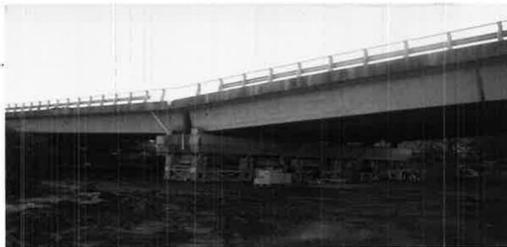
Fig. 46 - Viadotto Regi Lagni - abbassamento della livelletta stradale - Impalcato dopo l'abbassamento di una pila.
