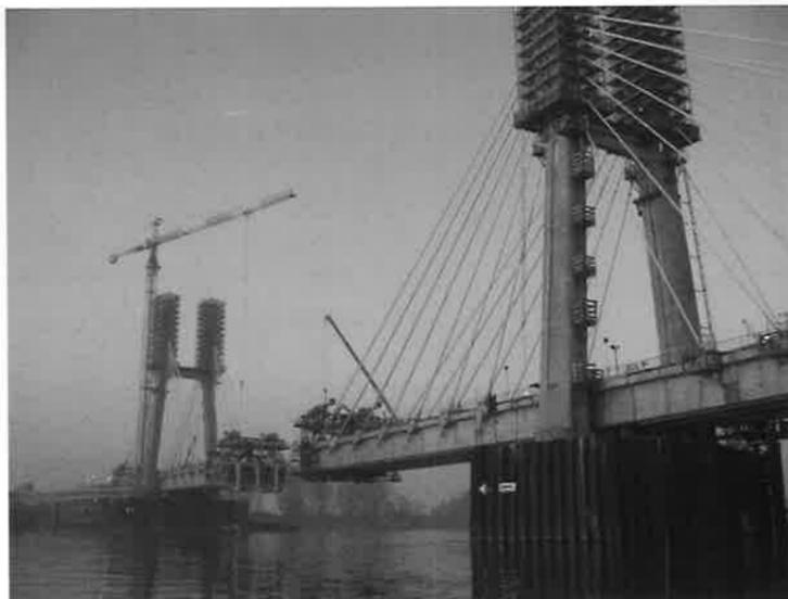
Fig. 2 - Ponte strallato sul fiume Po - Costruzione dell'impalcato strallato.
