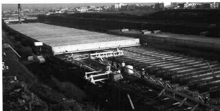
Fig. 35 - Galleria "Santa Chiara" - Posa in opera dei tegoli prefabbricati di copertura.
