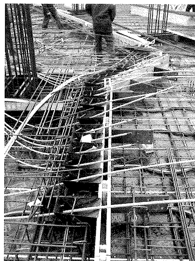
Fig. 6 : Particolare dei giunti provvisori
