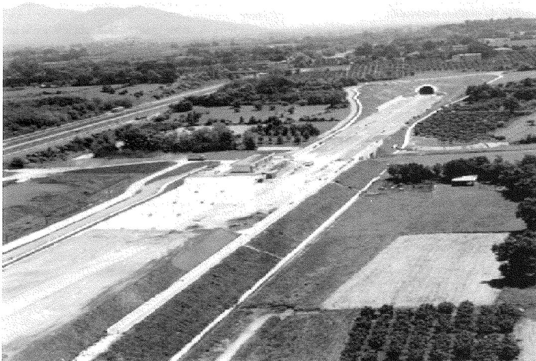
Figura 1 – Rilevato prima della rimozione della precarica
