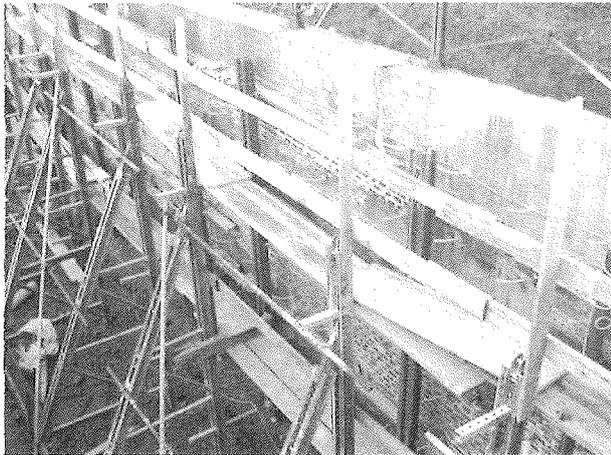
Figura 5.2 - Iniezione di malte nel muro
