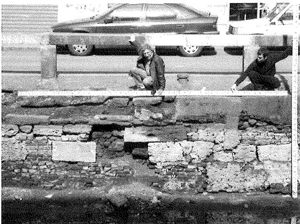
Figura 3.4 - Naviglio Grande in asciutta (grave erosione del muro)
