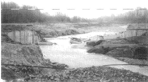
Foto 2 rottura della traversa di valle
