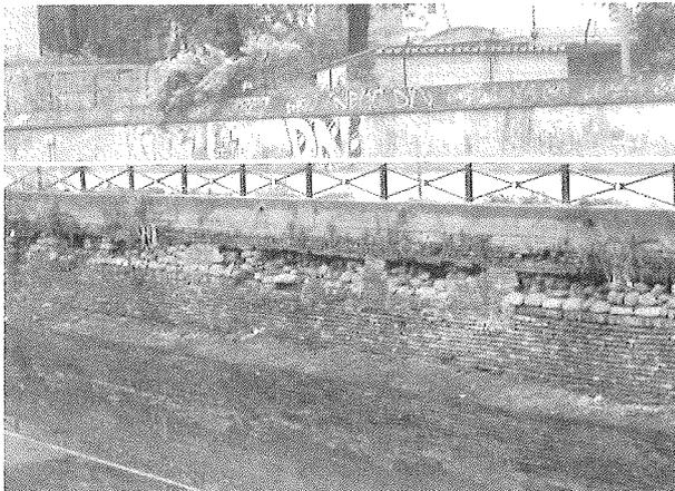
Figura 3.2 - Degrado per mancanza di materiale
