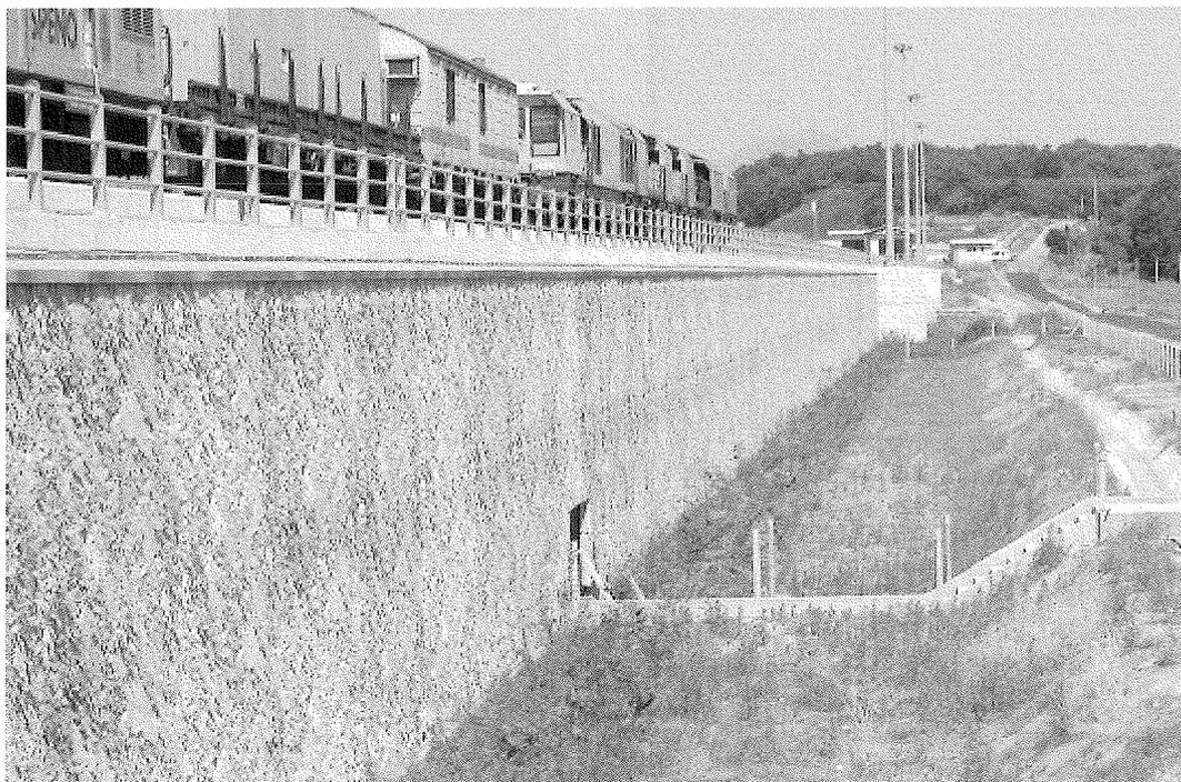
**Figura 9 – Parete terminata con passaggi pedonali sotto la struttura**
