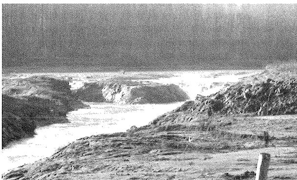
Figura 3, evoluzione dell'erosione dell'alveo fra le pile 2 e 3, registrata nel periodo dei lavori
