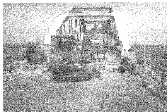
Foto n° 6: applicazione della precompressione longitudinale
