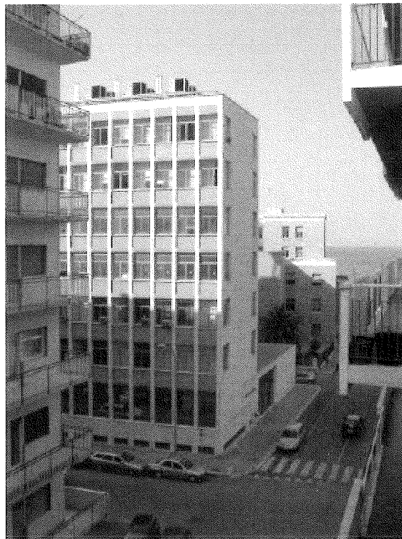
Foto 1 – Edificio sede della Corte dei Conti a Bari
