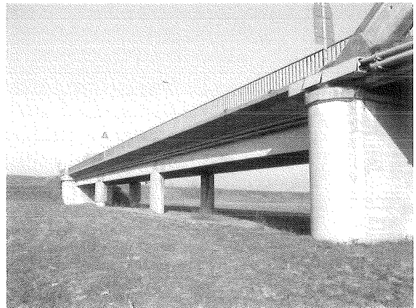
Foto n° 1: vista intradosso campate a trave prima dei lavori
