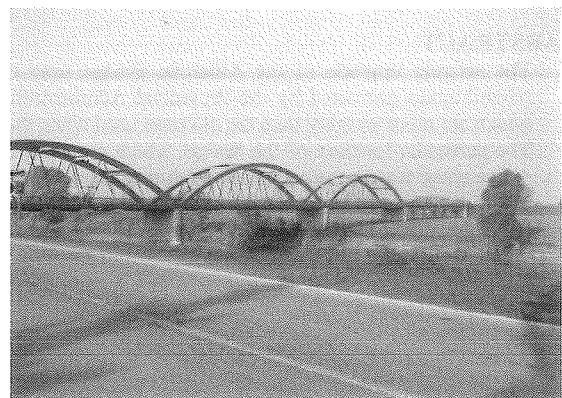
Foto n° 2: vista estradosso campate ad arco prima dei lavori
