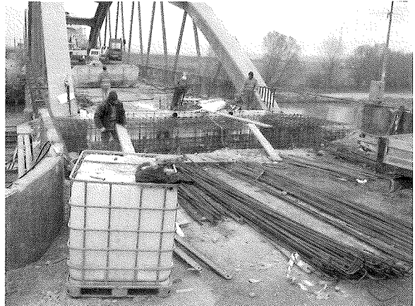
Foto n° 16: paratia di micropali spalla sinistra
