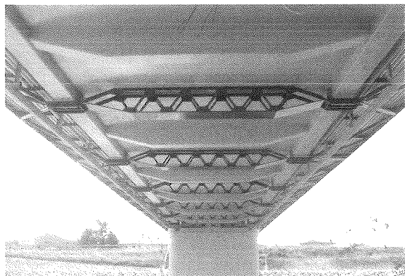
Foto n° 4: vista intradosso campate ad arco a lavori eseguiti
