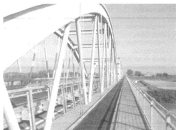
Foto n° 8: vista estradosso particolare nuovo sbalzo
