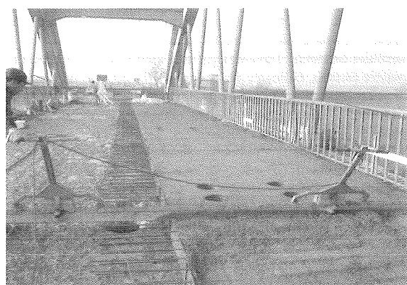
Foto n° 5: nuova soletta in calcestruzzo alleggerito
