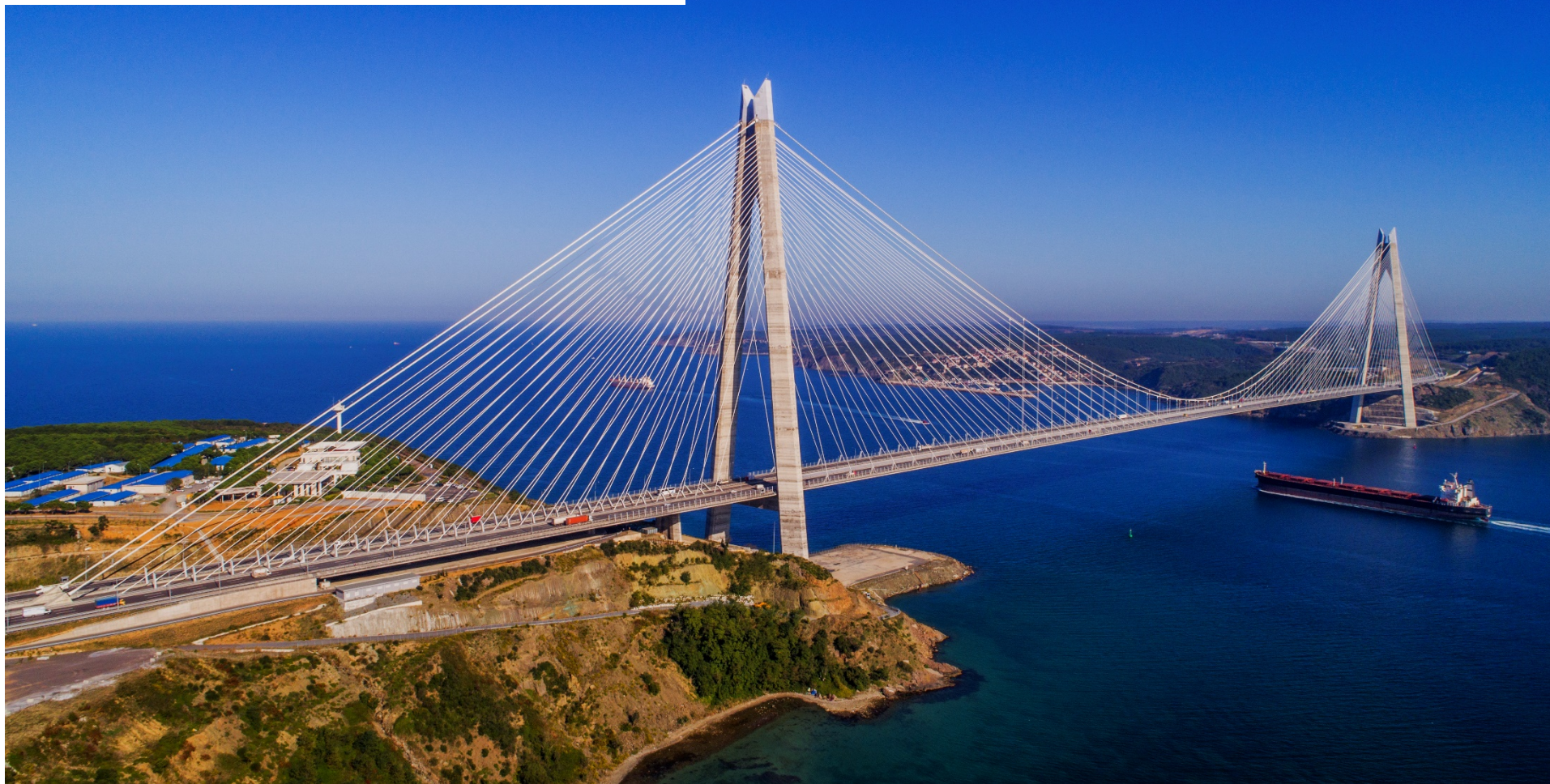
3° Ponte sul Bosforo (2016) ibrido sospeso-strallato B = 58,5 \text{ m} L_c = 1480 \text{ m} (record ponti con ferrovia)
