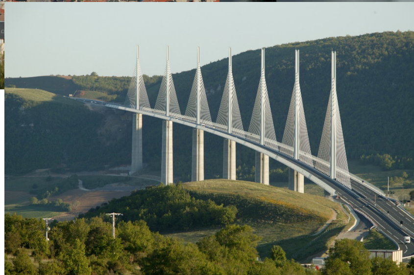
viadotto Millau 2460 m (2004)
